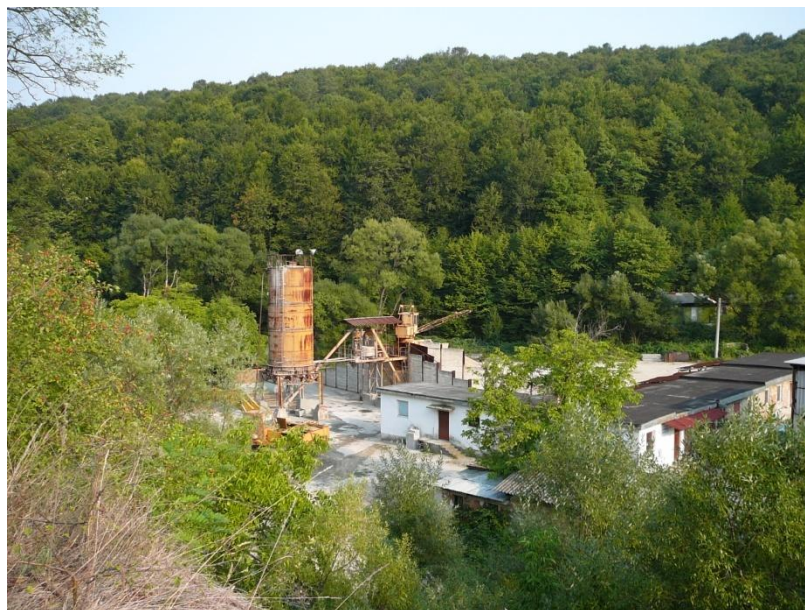
Поглед към строителната площадка
