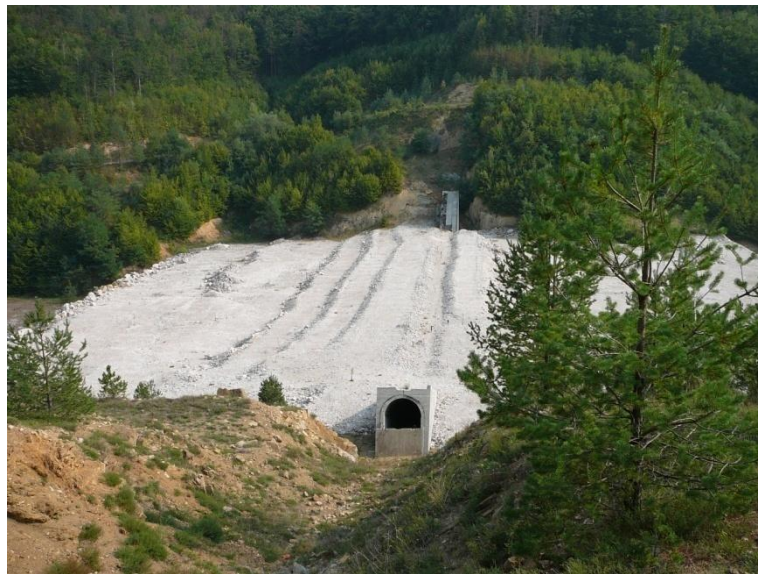
Поглед към инжекционната галерия
