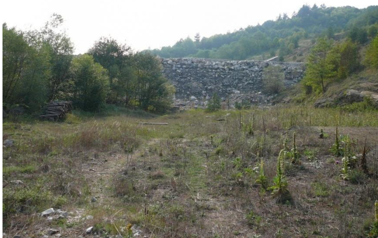
Поглед от водната страна към язовирната стена
