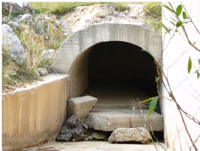
Поглед към входа на отбивното съоръжение
