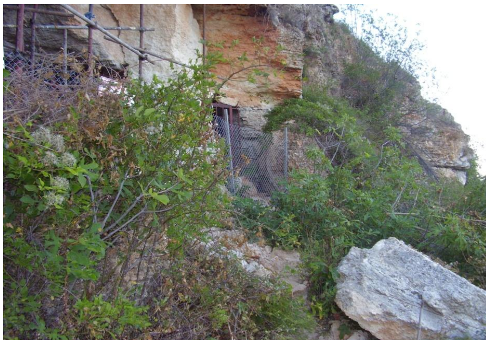
Фиг. 2.12. Обрушване на скални блокове при входа на скалната църква „Св. Св. Константин и Елена“ след земетресението при с. Камен бряг на 05.08.2009 г., M_s = 5.0 (сн. К. Костов, публ. в Dobrev et al., 2014)
