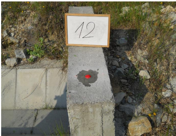
Фигура 6. Стабилизиране на гъбовиден болт в съоръжения
