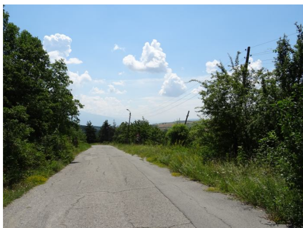
Силно наклонените ел.стълбове при левия борд извън обхвата и в рамките на свлачището
