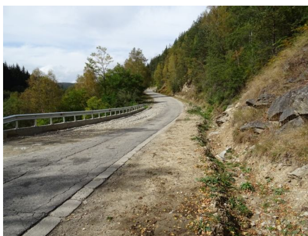
Земна отводнителна канавка
