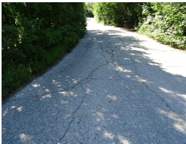
Деформации по пътното платно при km 3 +280
