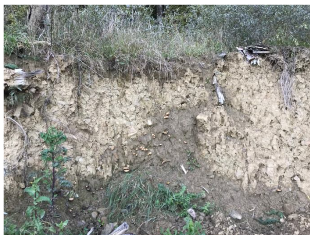
Влажни петна по изкуствен откос при масивната жилищна сграда
