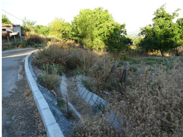
Състояние на отводнителната канавка
