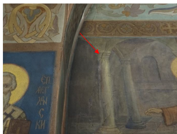
Деформации във вътрешната част на храма
