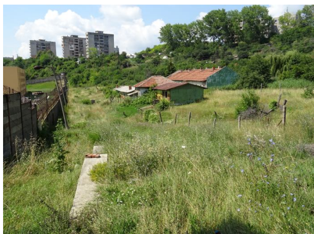
Състояние на част от стената на пилотна система 2
