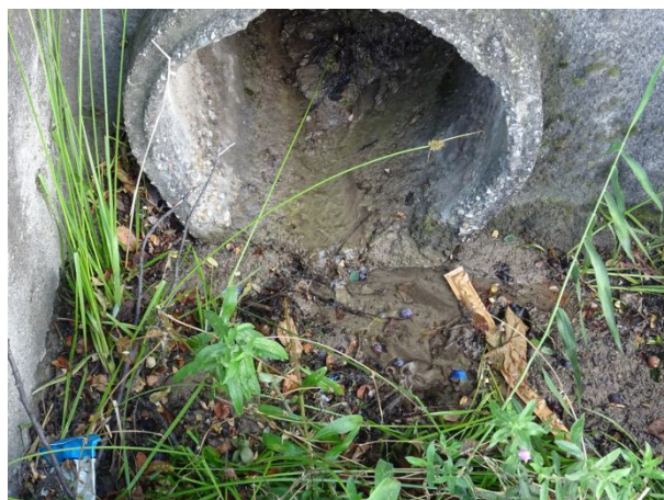
Състояние на приемната ст.б. шахта и отходната тръба
