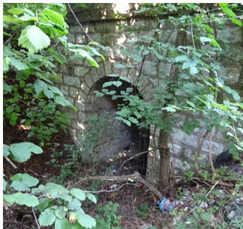
Отводнителни съоръжения в границите на свлачищния участък
