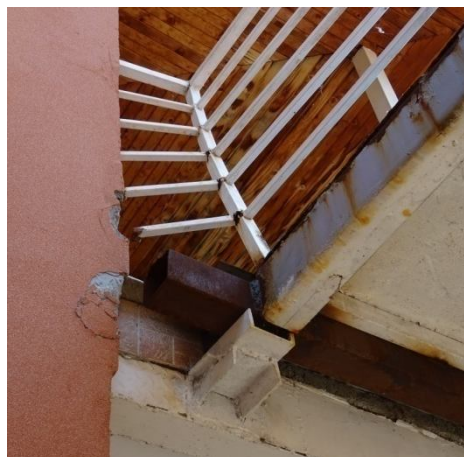
Деформации на усукване в централната част на комплекса
