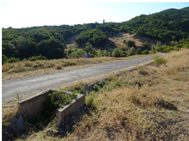
Нарушени отводнителни съоръжения
