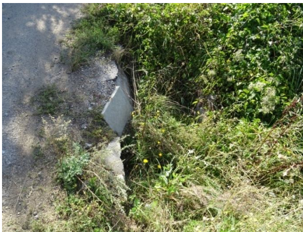
Състояние на отводнителната канавка и водосточната тръба под черния път
