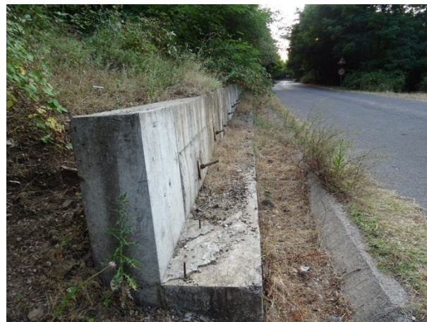
Долна пилотно-анкерна конструкция
