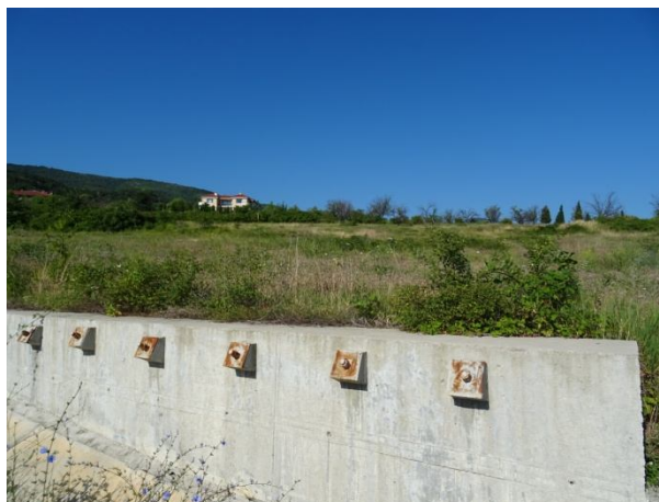
Анкерирана пилотна стена и теренът над нея
