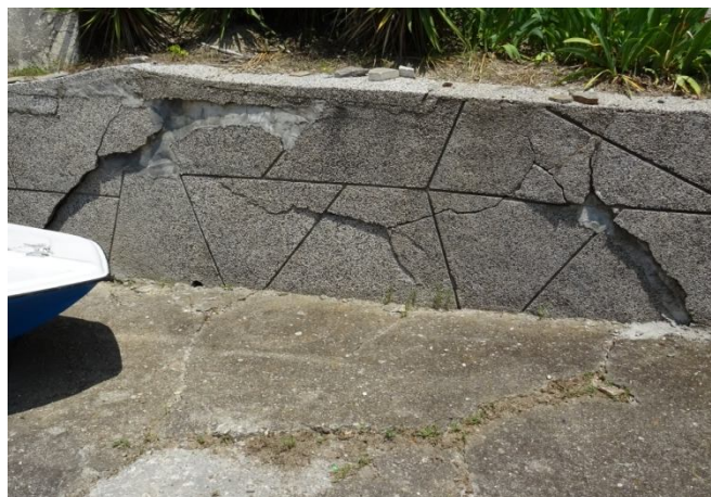
Деформации по облицовката на терасираща подпорна стена
