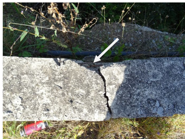
Скъсана надлъжна монтажна армировка при вертикалните пукнатини
