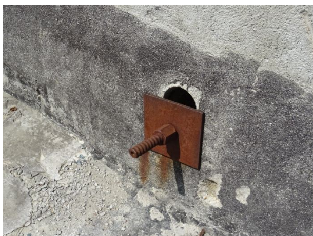
Състояние на констатираните при предишен оглед неизправни анкери
