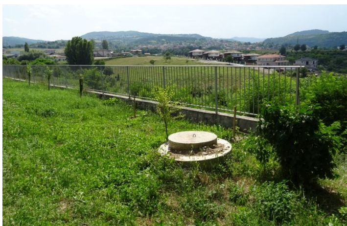
Състояние на подпорно съоръжение
