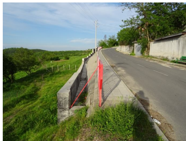
Укрепителни мероприятия при свлачищен участък в с. Габрово
