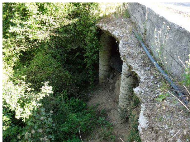
Част от пилотите са оголени със засилена ерозия на почвата между тях. Дъгообразната пукнатина очертава вероятната засегната зона от пътното платно.
