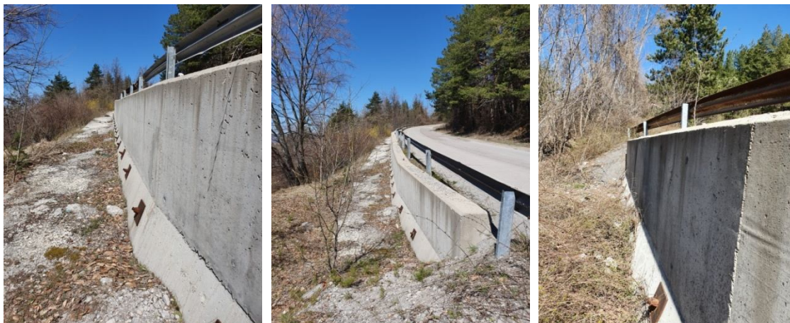
Изпълнена пилотно-анкерна конструкция при km 5 +200
