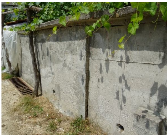
Отместена ламела по дилатационната фуга
