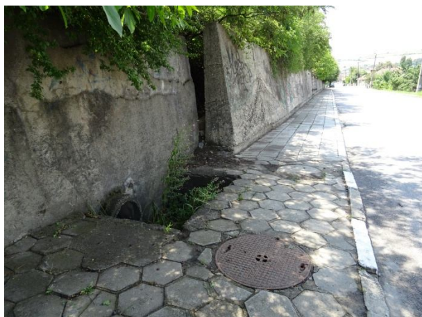
Състояние на приемната ст.б. шахта и отходната тръба
