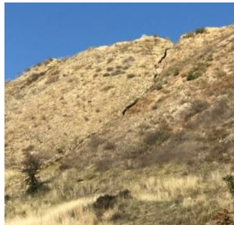
Табан-насипище и оврагообразуване по южния му откос
