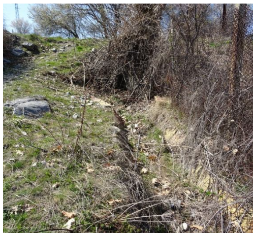
Натрупани клони в двата края на канала под водостока
