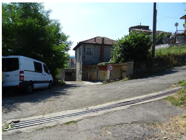
Съществуваща отводнителна шахта
