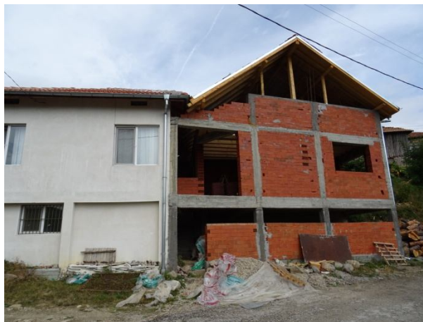
Новострояща се сграда в имот с пл.сн. № 47
