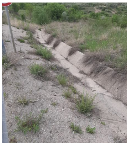
Облицовани повърхностни канавки
