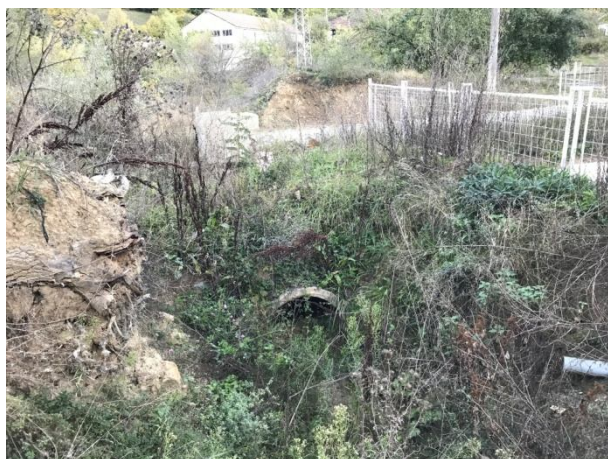
Състояние на входа и изхода на водостока
