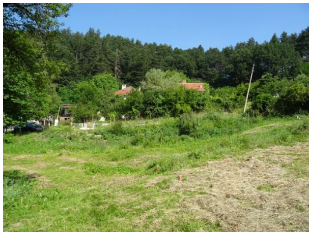
Изглед към свлачищния участък
