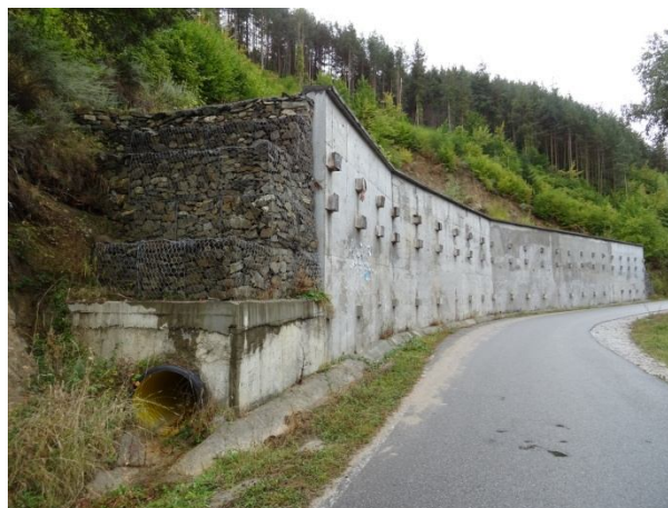
Силов пилотно-подпорна конструкция
