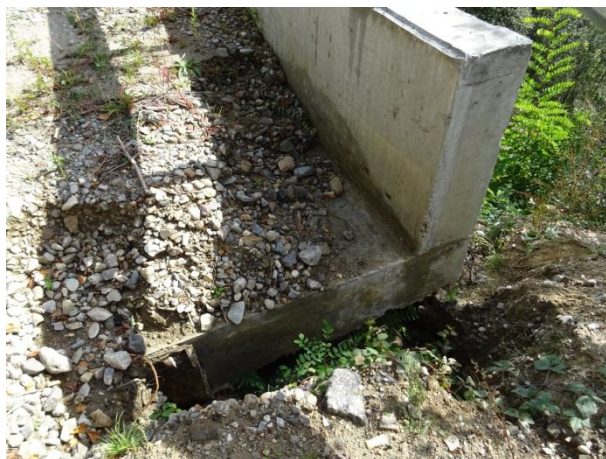
Подкопан ростверг от свободно стичащи се повърхностни води
