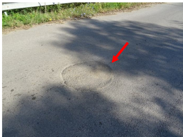
Състояние на приемната шахта на водостока, минаващ под пътя
