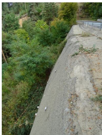
Армонасипна гравитачна конструкция
