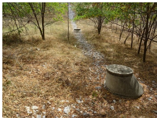
Състояние на дренажни ребра и събирателни шахти
