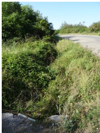
Състояние на отводнителната канавка и водосточната тръба под черния път
