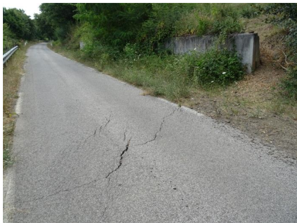
Деформации в източния край на подпорното съоръжение
