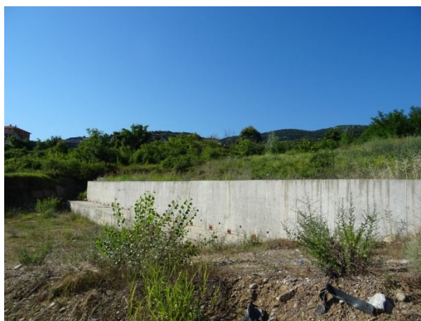
Пилотна подпорна стена в езика на свлачището
