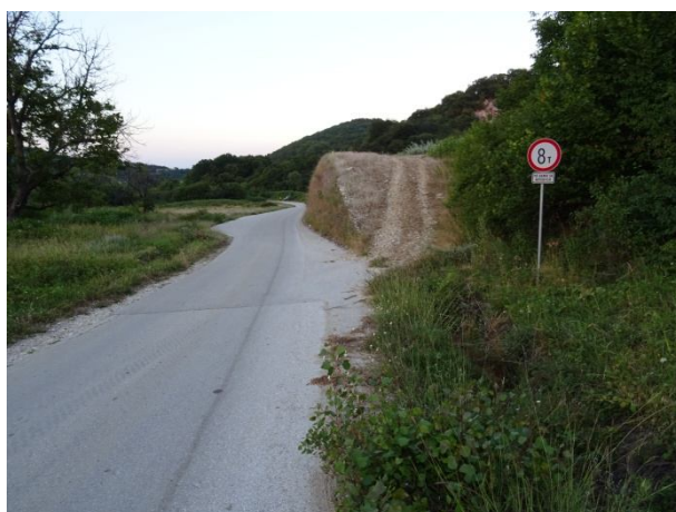
Състояние на укрепения участък
