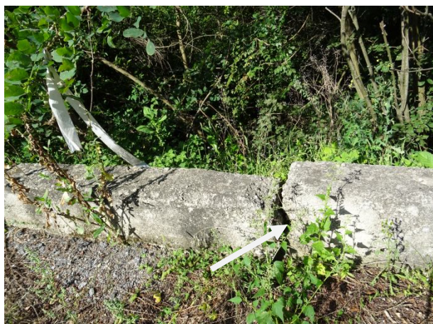
Скъсана надлъжна монтажна армировка при вертикалните пукнатини
