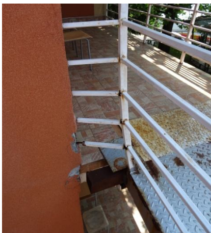
Деформации на усукване в централната част на комплекса
