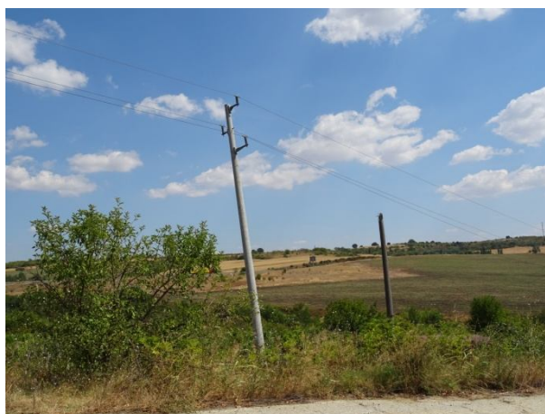
Подменен електрически стълб
