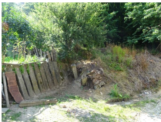
Аварийно укрепване на откоса с траверси
