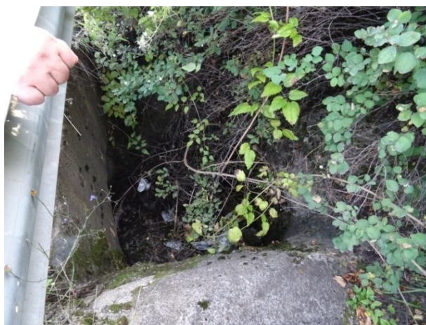
Състояние на приемната шахта на водостока, минаващ под пътя
