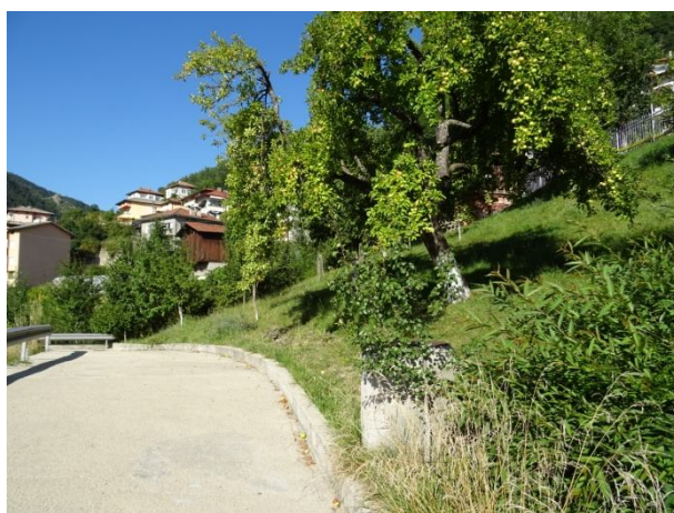
Изглед към терена над укрепения свлачищен участък
