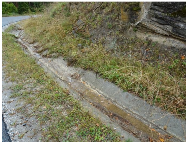
Облицована повърхностна канавка
