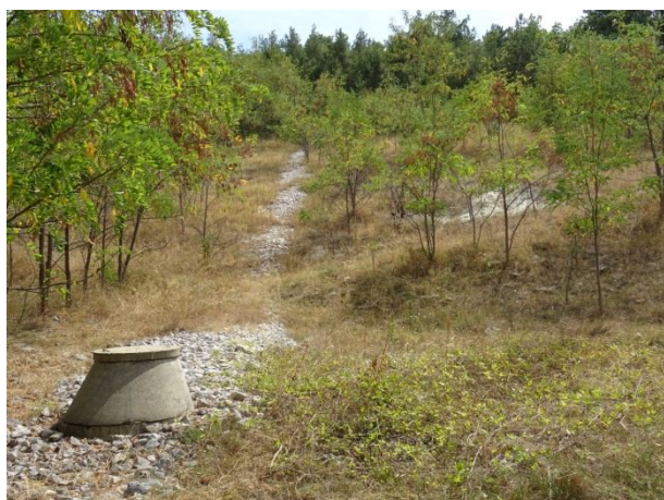
Състояние на дренажни ребра и събирателни шахти
