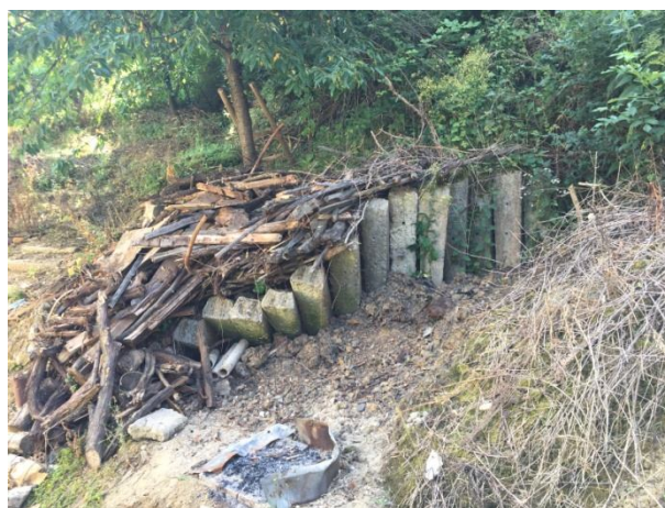
Аварийно укрепване на откоса с траверси
