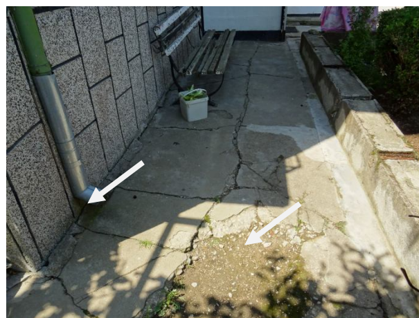
Пукнатини по сграда на ул. „Еделвайс” № 20 и състояние при водостока
