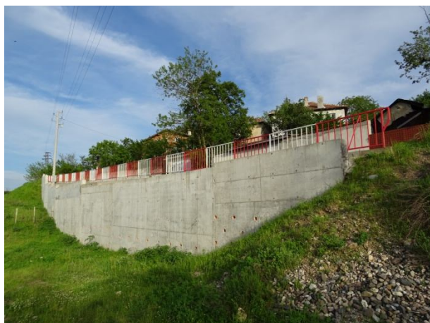
Укрепителни мероприятия при свлачищен участък в с. Габрово
