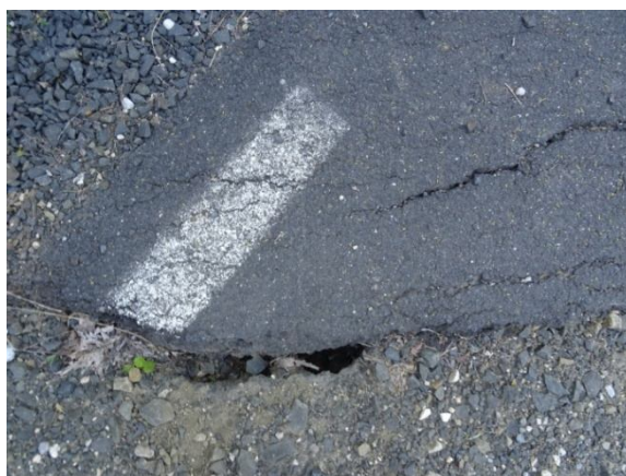
Деформации при десния борд
