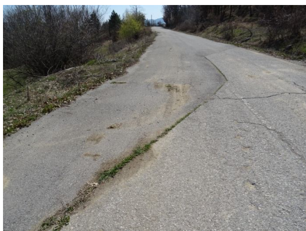
Деформации в двата края на укрепения участък
