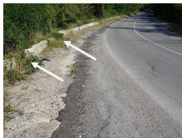
На места липсва част от подпорната стена
