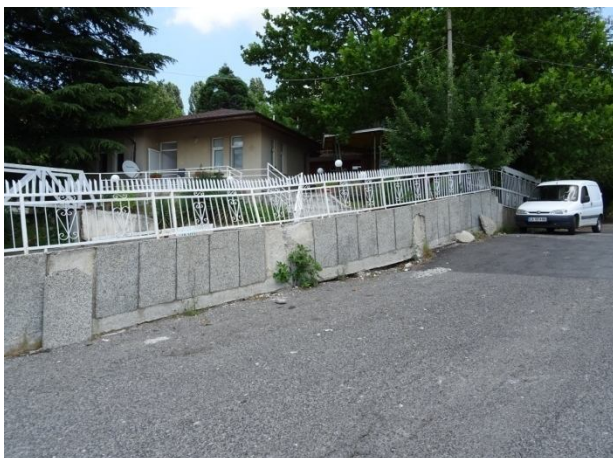
Деформации по облицовката на терасираща подпорна стена
