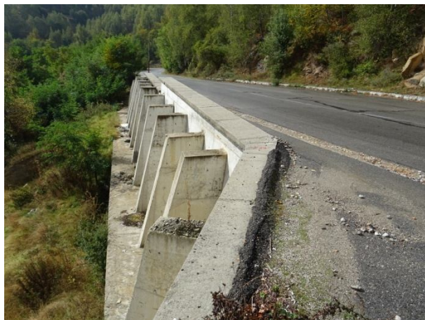
Стоманобетонна рамкова пилотно - ростверкова система
