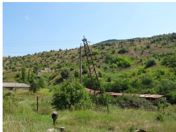
Състояние на терена под откоса на свлачището и наклонения ж.р.стълб
