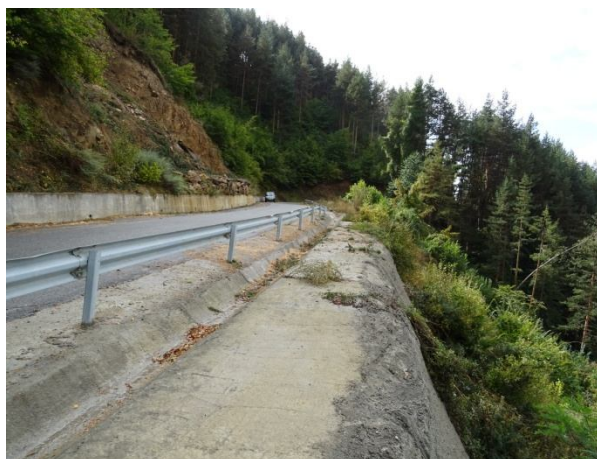
Армонасипна гравитачна конструкция
