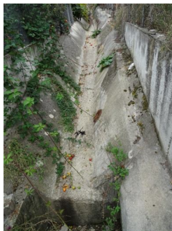
Корекция на съществуващо дере и отвеждане на водите му в р. Бистрица
