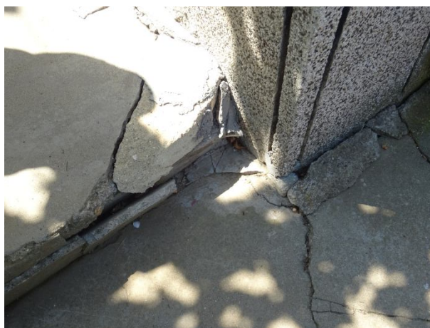
Пукнатини по сграда на ул. „Еделвайс” № 20 и състояние при водостока
