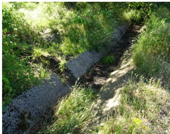
Отводнителни съоръжения в границите на свлачищния участък
