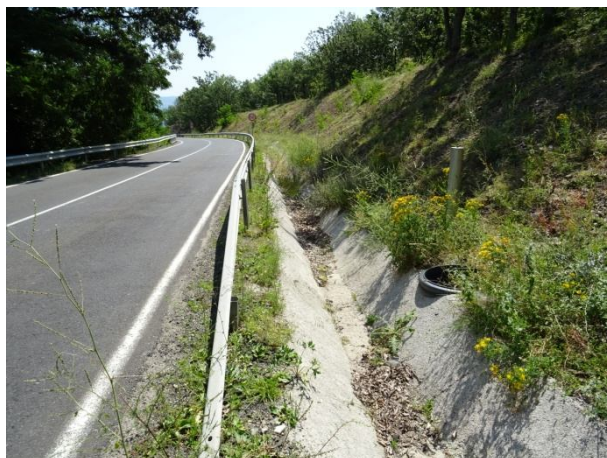
Отводнителни съоръжения в границите на засегнатия участък
