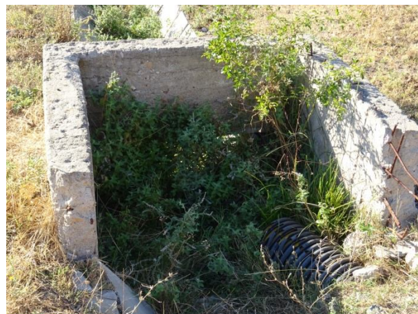
Нарушени отводнителни съоръжения
