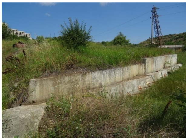
Състояние на пилотна система 1 над трафопоста
