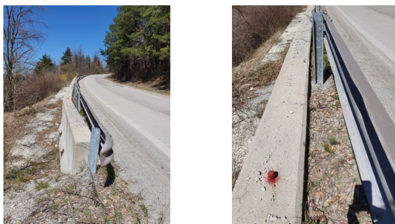
Изградена контролно-измервателна система
