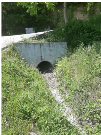
Шахта с облицована канавка и подкопен дренаж
