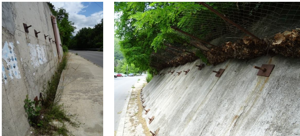
Състояние на подпорната стена
