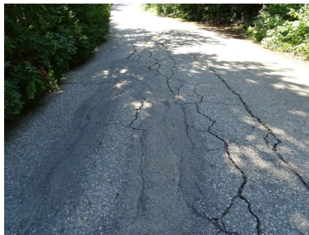
Деформации по пътното платно при km 3 +280
