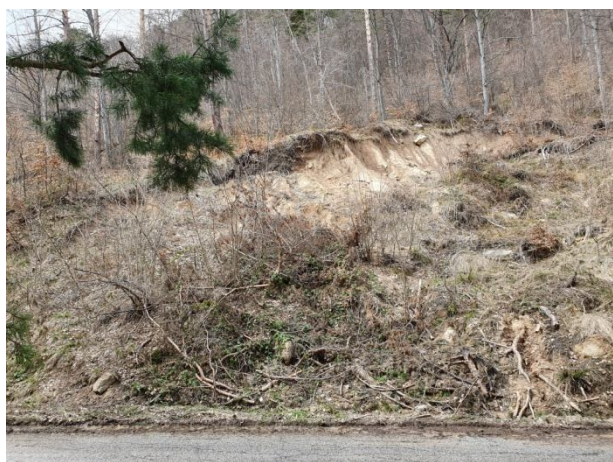
Активно състояние на свлачищен участък при km 29 +050
