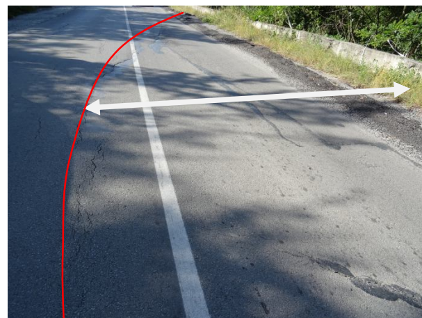
Част от пилотите са оголени със засилена ерозия на почвата между тях. Дъгообразната пукнатина очертава вероятната засегната зона от пътното платно.
