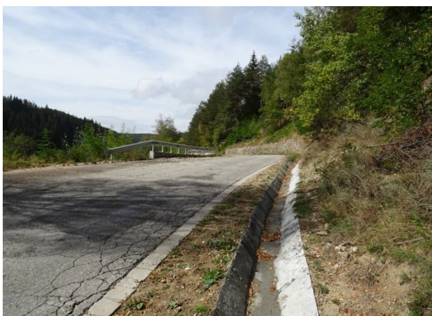
Облицована повърхностна канавка
