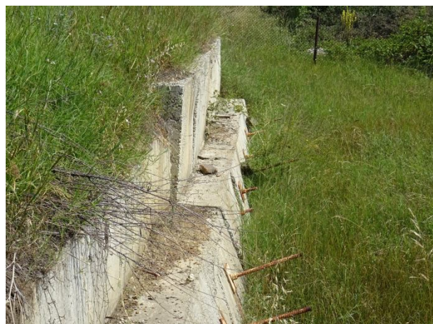
Състояние на пилотна система 1 над трафопоста
