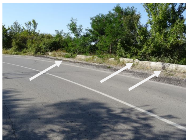
На места липсва част от подпорната стена
