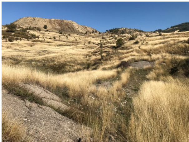
Табан-насипище и оврагообразуване по южния му откос
