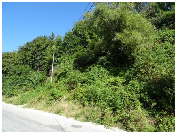
Общ изглед към свлачищния участък от ул. „Миньорска”
