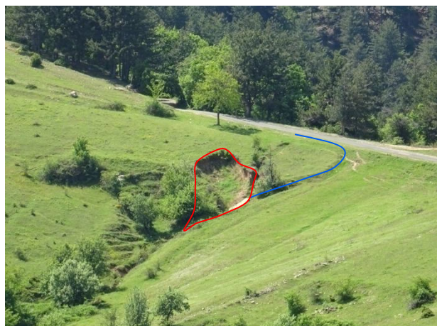
Свлачищен циркус и водосточен улей
