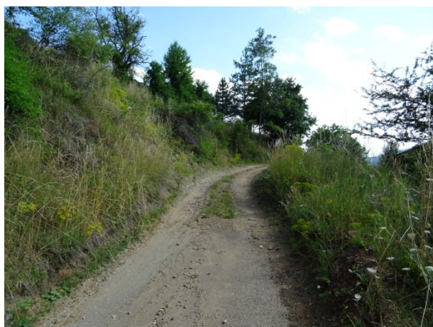
Състояние на уличните платна, преминаващи през свлачищния участък
