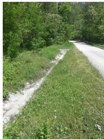
Шахта с облицована канавка и подкопен дренаж
