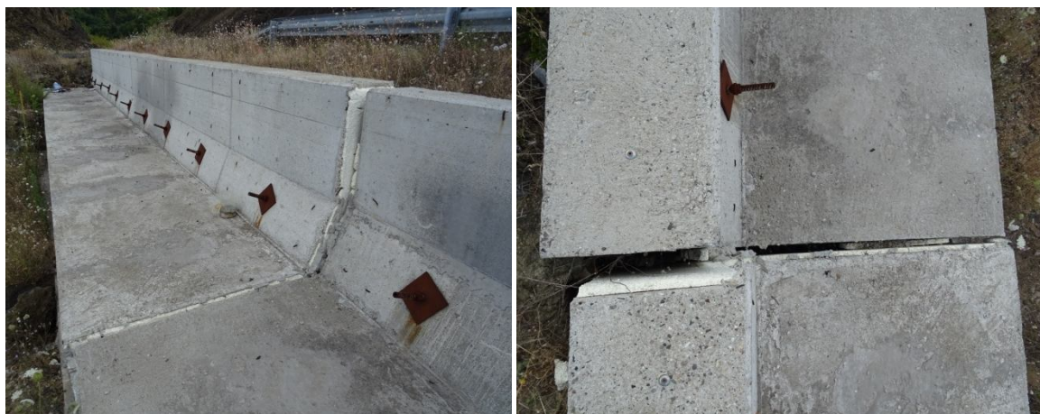
Дилатационна фуга между южния и средния сегмент на съоръжението
