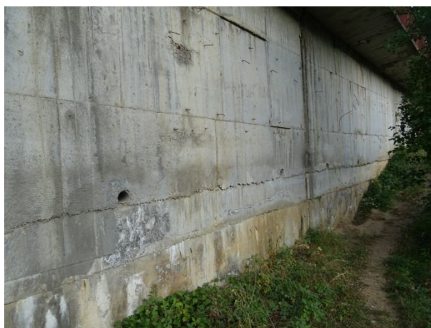
Общ изглед на укрепителното съоръжение
