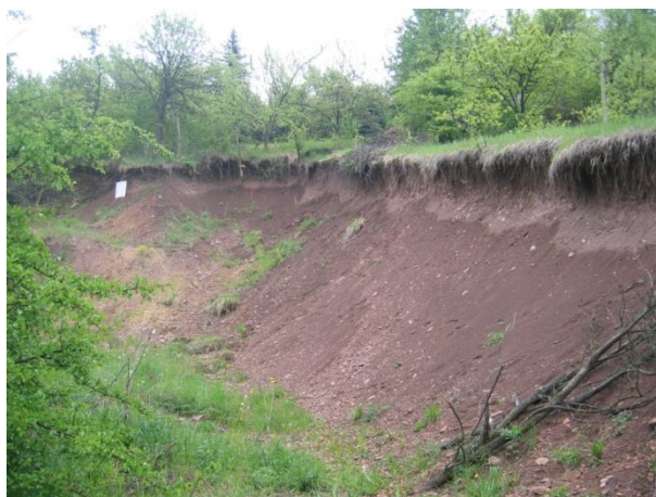
Главен свлачищен откос
