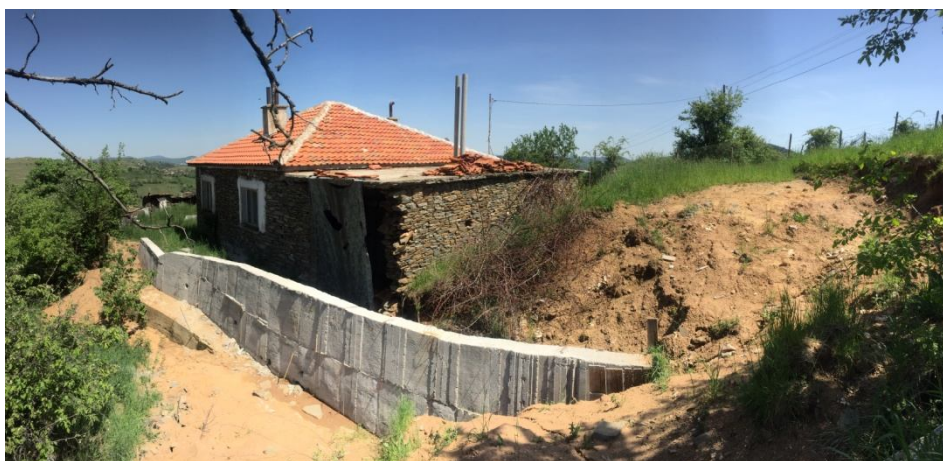
Подпорна стена под засегнатата къща
