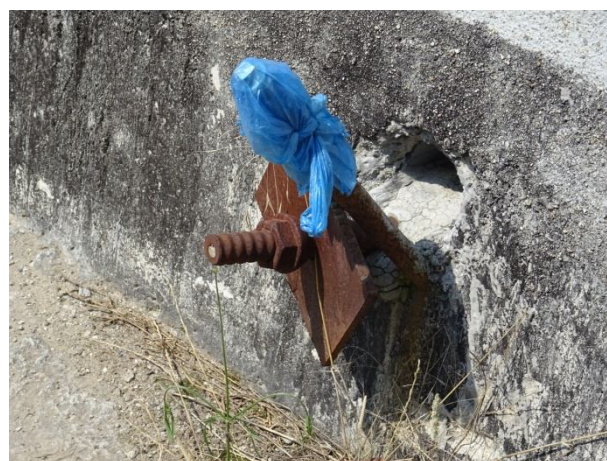
Състояние на констатираните при предишен оглед неизправни анкери
