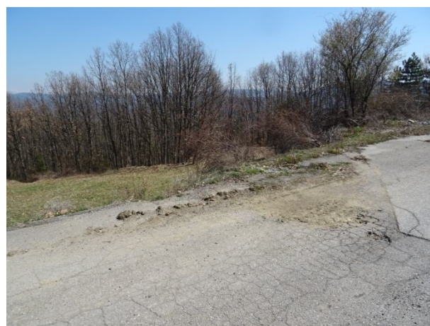
Деформации в двата края на укрепения участък
