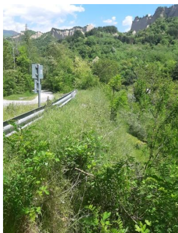
Затревена армонасипна конструкция
