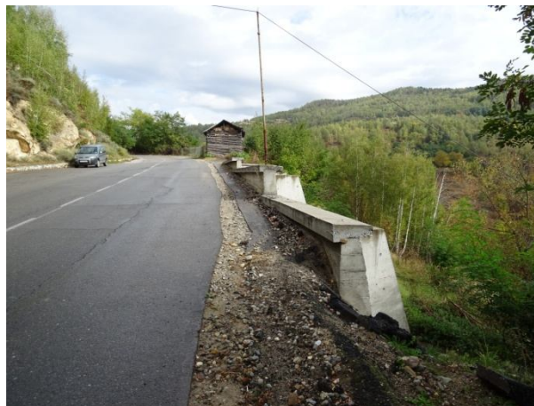
Стоманобетонна рамкова пилотно - ростверкова система
