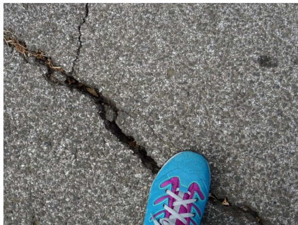
Деформации в източния край на подпорното съоръжение
