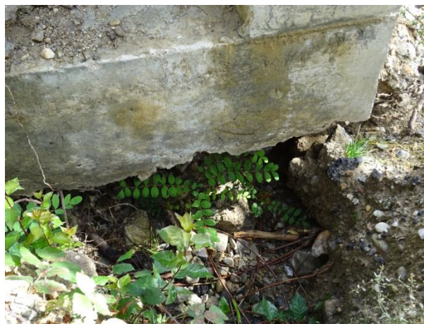
Подкопан ростверг от свободно стичащи се повърхностни води
