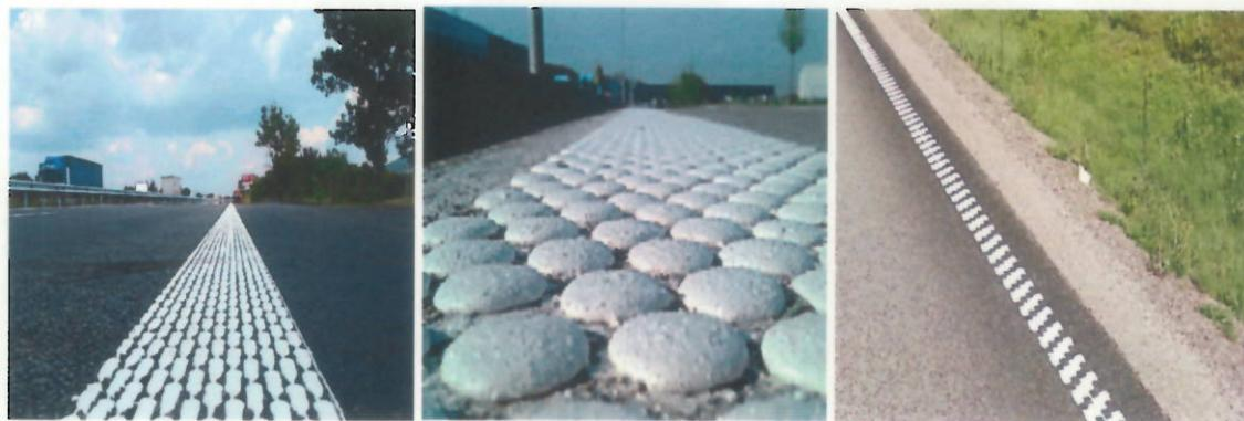
Фиг. III.5. Наддължна релефна шумна пътна маркировка
