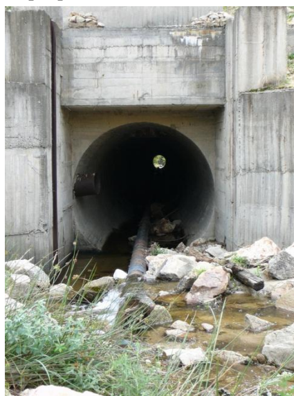
Поглед към входа на отбивното съоръжение и основен изпускател
