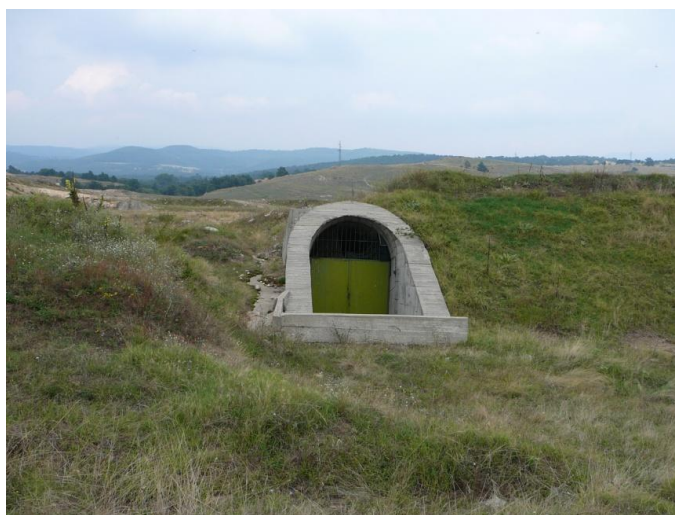
Вход на инжекционната галерия
