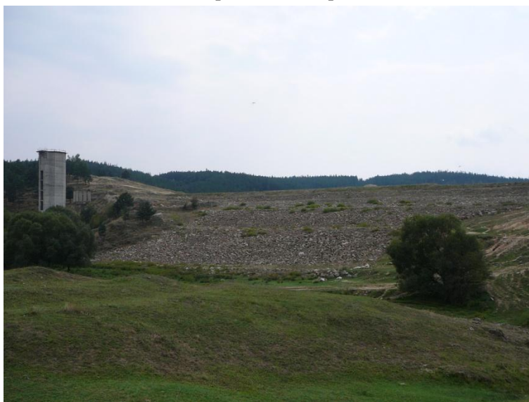
Поглед от водната страна към язовирната стена
