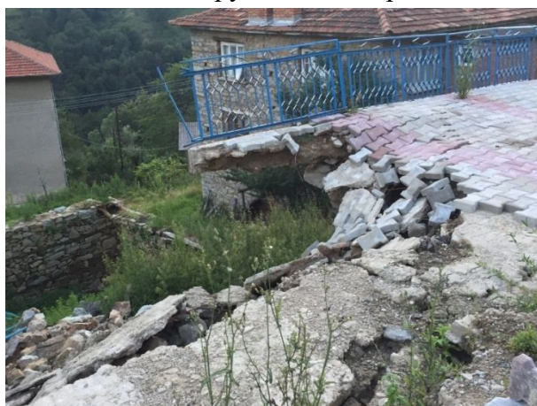
Пропадане и изкривяване на оста на съоръжението /2018 г./
