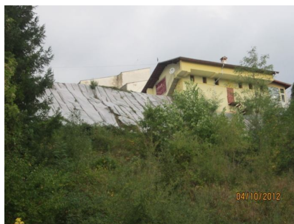
Главен свлачищен откос, покрит с навес на конструкция /октомври, 2012 г./
