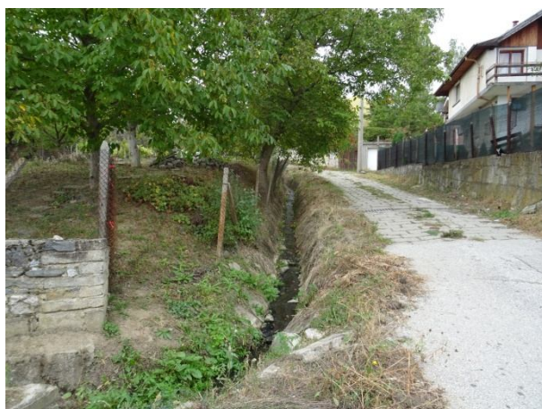
Отводнителни канавки в застроената част на свлачището
