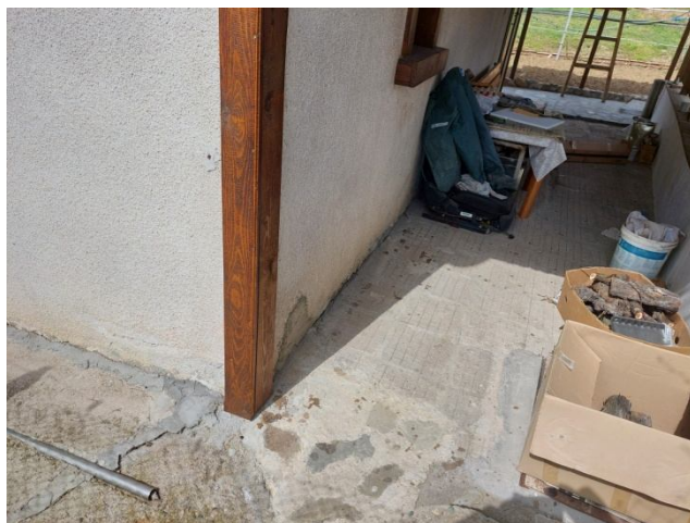
Напуквания между фасадите на къщата и плочника около тях
