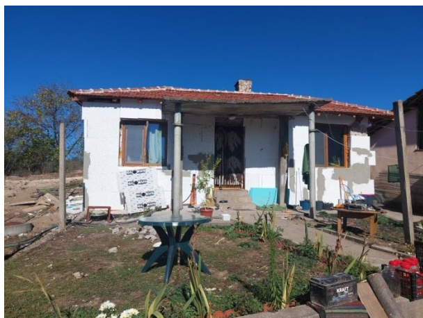
Ремонтни дейности чрез външно и вътрешно саниране
