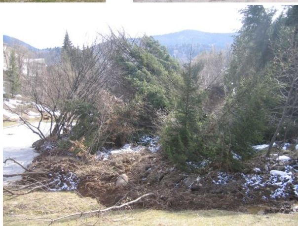
Състояние на свлачищния участък след възникването му /март, 2005 г./
