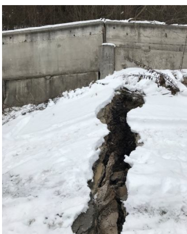
Разрушена бетонова оградна стена и свлачищни деформации /2022 г./
