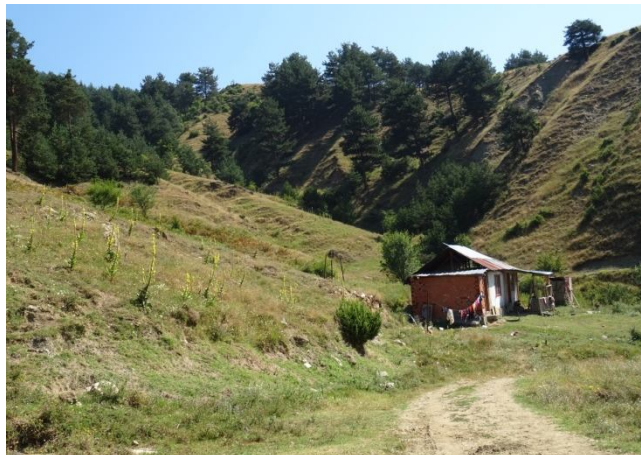
Жилищна постройка в близост до левия свлачищен борд
