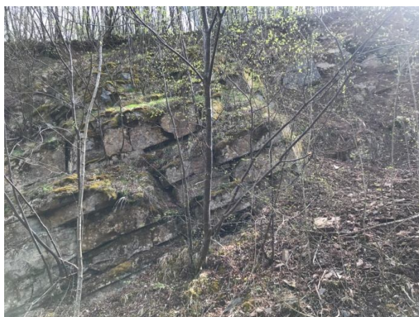
Система от отворени пукнатини в масива и „висящ“ скален блок /11.04.2022 г./
