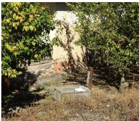
Каптиран извор в долната част на свлачищен участък № 1
