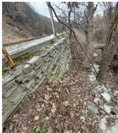
Слягания по тротоара, разположен откъм откоса на р. Бистрица
