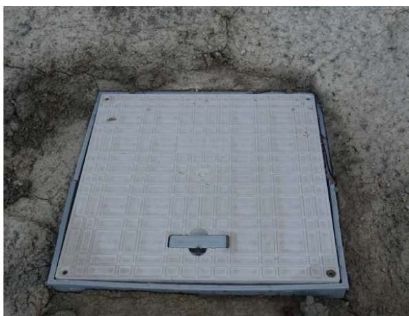
Изградена стаманобетонена шахта за ревизия на кабел
