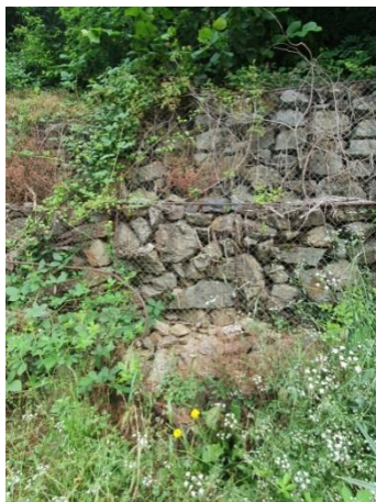
Укрепващи ската габиони по вътрешния пътен откос
