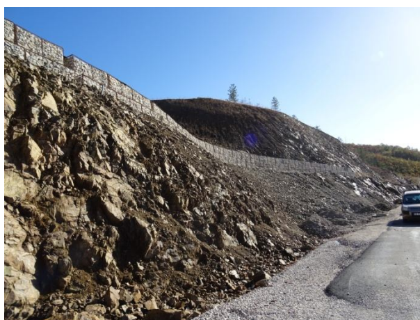
Габионна контрафорсна стена
