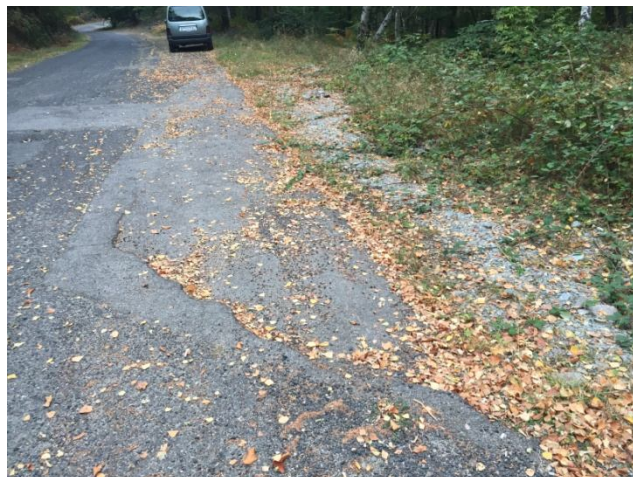
Пукнатина на пътя, повтаряща главния свлачищен откос и граница на преасфалтиране /2018 г./
