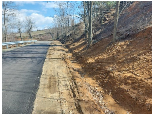
Отводнителен пътен окоп
