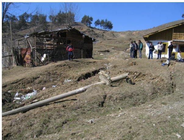
Разрушен ел. стълб, 2005 г.
