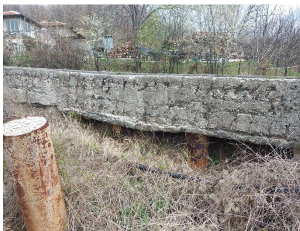
Корозирали железни тръби и оголена армировка от ростверга
