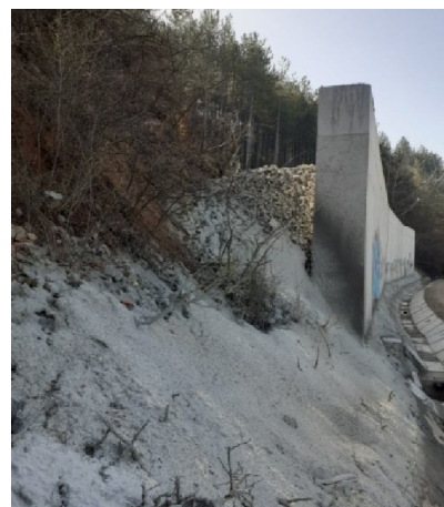
Изпълнен обратен насип от трошен камък
