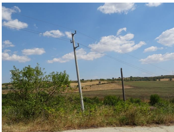
Подменен електрически стълб
