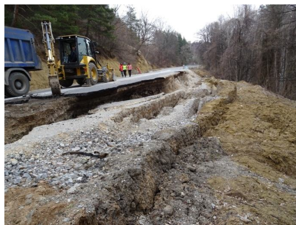
Разрушени и отместени габиони /09.03.2021 г./
