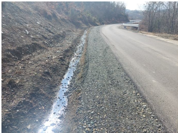
Отводнителен пътен окоп
