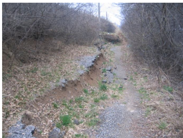
Главен свлачищен откос на ул. „Еделвайс“ /2008 г./
