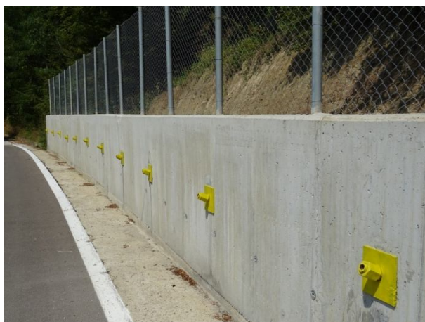
Изградена анкерирана горна опорна стена
