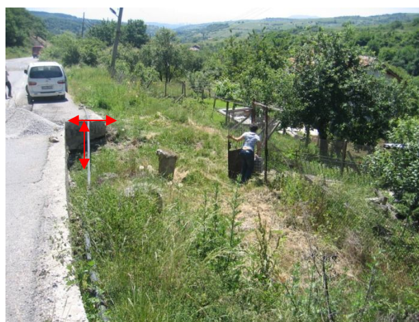
Преместване и пропадане на банкета и ростверка
