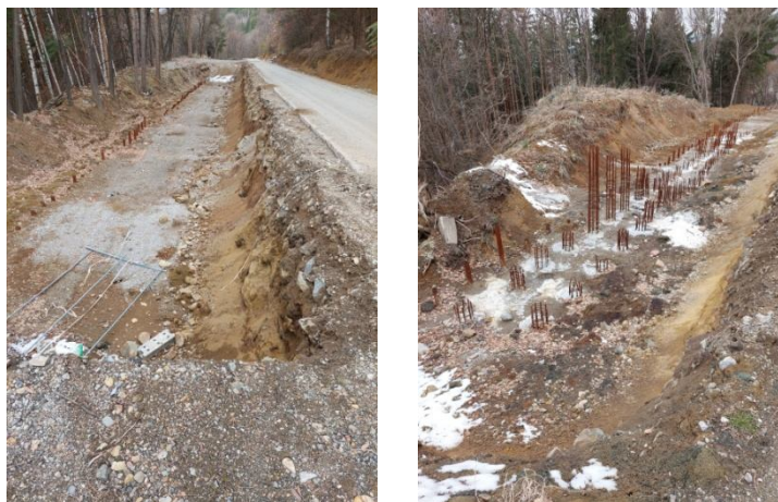
Строителен изкоп със започната пилотна конструкция /16.03.2022 г./
