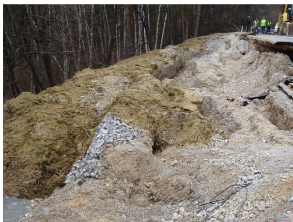
Разрушени и отместени габиони /09.03.2021 г./
