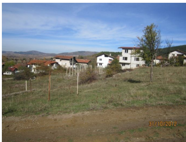
Общ изглед на свлачищния участък, 2012 г.
