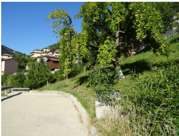
Изглед към терена над укрепения свлачищен участък, 2020 г.
