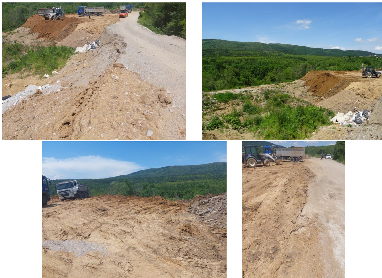
Насипване на земни маси в свлачищното тяло
