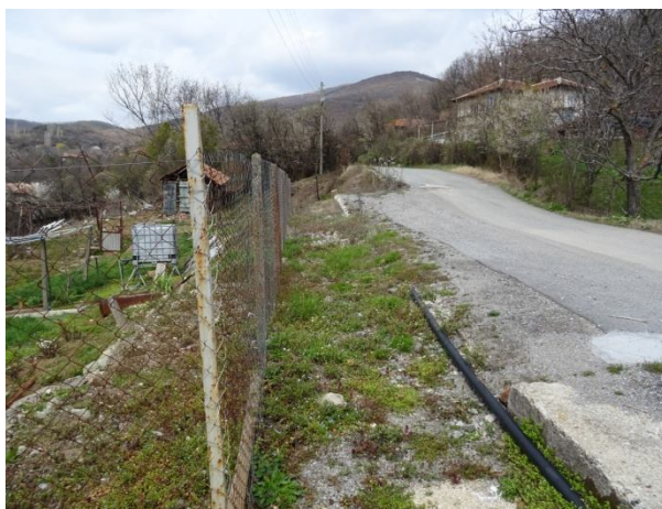
Повърхностно изведен главен водопровод
