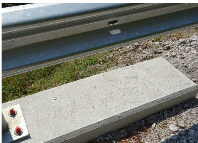
Контролни репери, разположени на укрепителното съоръжение
