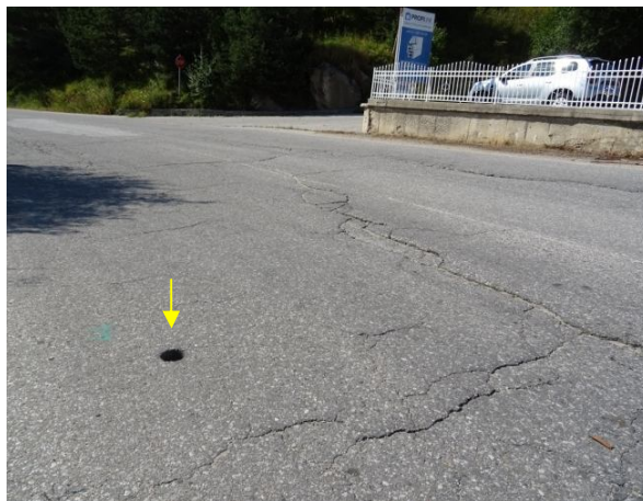
Сондажен пробод и напукана асфалтова настилка над главния свлачищен откос
