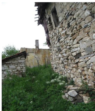
Демонтиран покрив на сграда
