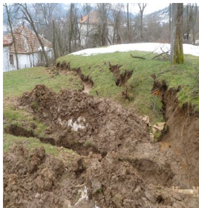
Главен свлачищен откос
