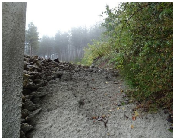
Изпълнен обратен насип от трошен камък
