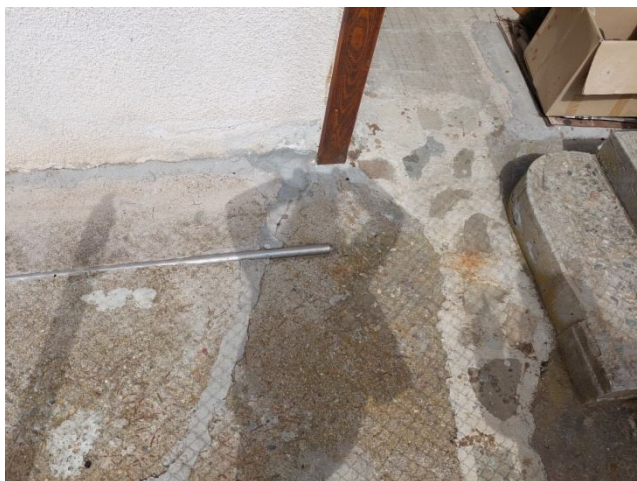
Напуквания между фасадите на къщата и плочника около тях
