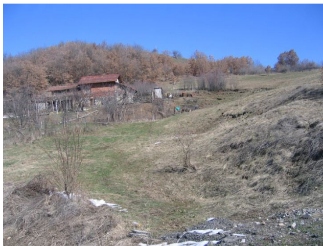
Общ изглед на свлачищния участък /03.2010 г./
