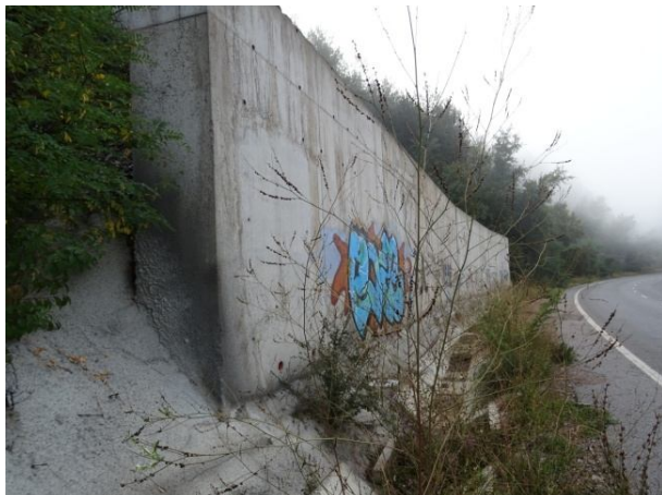
Изпълнен торкрет бетон
