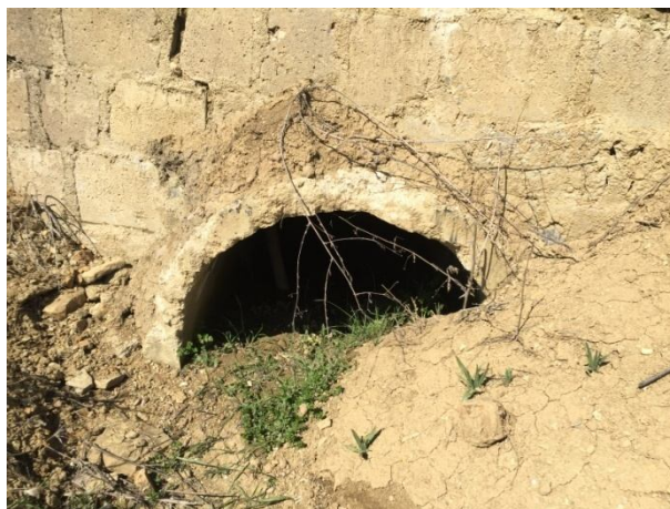
Запушване на водосток под път Ш-6222 /април, 2020 г./
