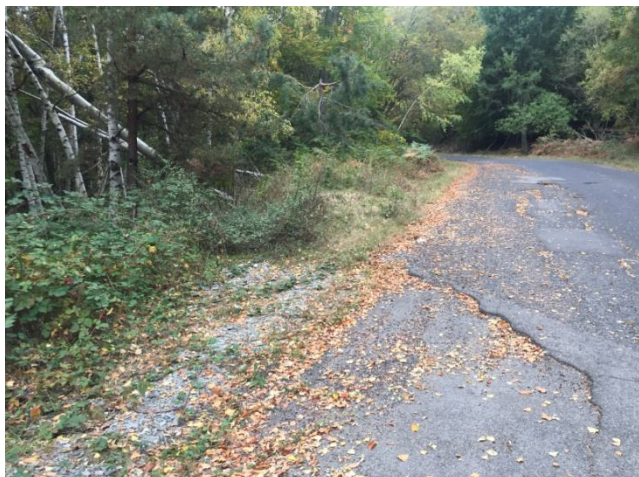
Пукнатина на пътя, повтаряща главния свлачищен откос и граница на преасфалтиране /2018 г./
