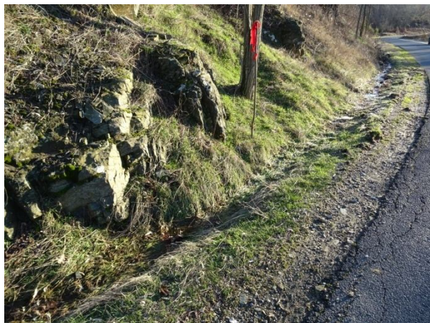
Открита земна канавка, 2021 г.
