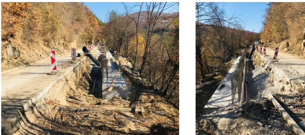
Изграждане на геозащитно съоръжение на път SFO 1471 при km 8 +360 , 2022 г.
