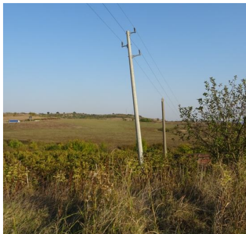
Наклонен ел. стълб, 2019 г.
