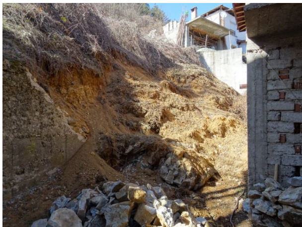
Разрушена подпорна стена, 2022 г.
