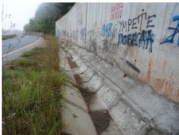
Възстановена отводнителна канавка на пътното платно
