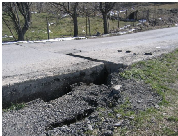
Оголване на ростверка и отваряне на фуга, 2010
