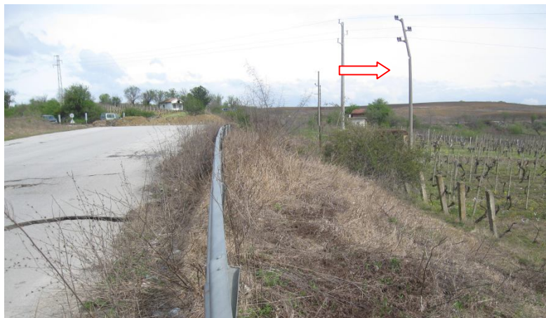
Нарушен ел. стълб, 2015 г.
