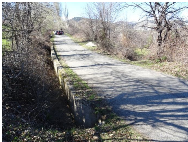
Общ изглед на изградената подпорна стена /март, 2023 г./
