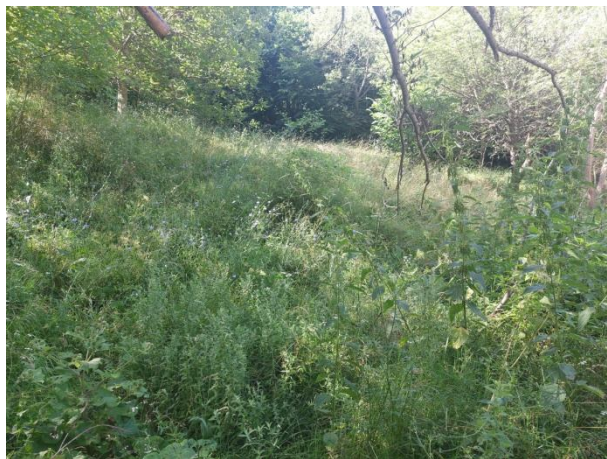
Общ изглед на свлачищен участък 3
