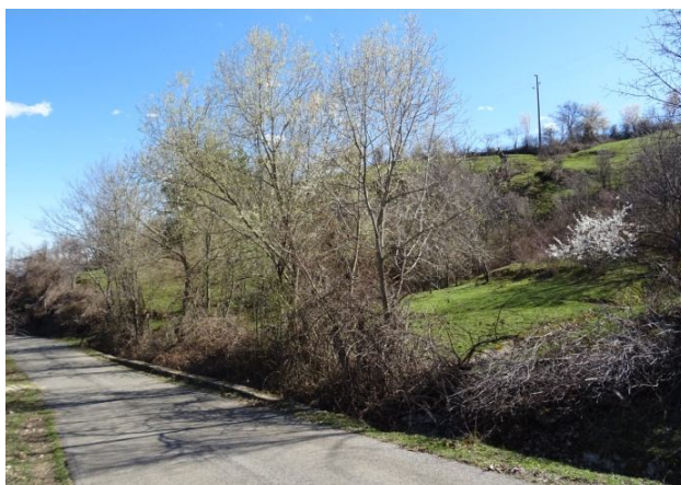
Общ изглед на укрепения свлачищен участък /март, 2023 г./
