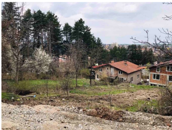
Жилищна сграда /лява/, зад която е реализирана подпорна стена
