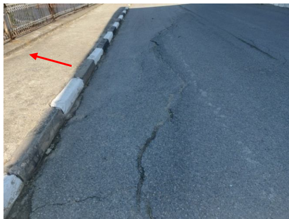
Деформации по короната на стената
