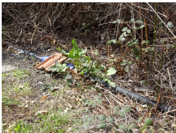
Повърхностно изведен главен водопровод
