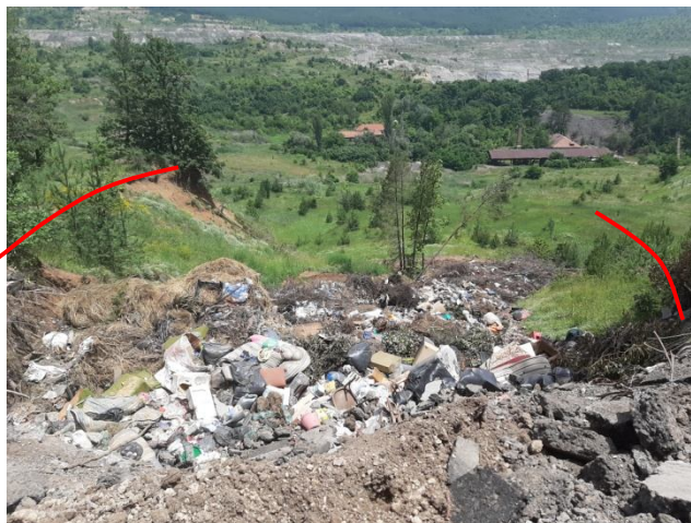
Общ изглед на свлачищния участък /2021 г./
