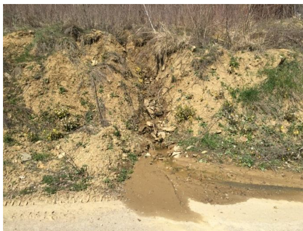
Оврагообразуване с дренiranje на води към път III-6222 /април, 2020 г./
