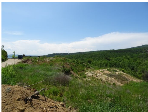
Главен свлачищен откос и десен борд в източната част на свлачищния участък
