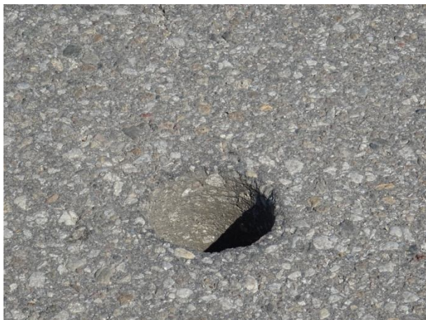
Сондажен пробод и напукана асфалтова настилка над главния свлачищен откос
