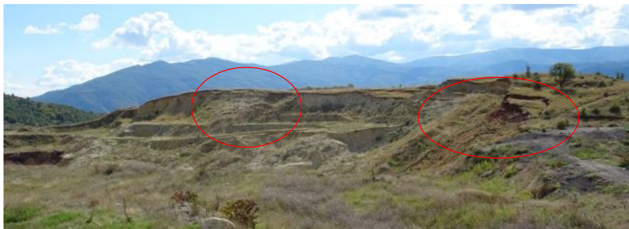
Изглед към котлована /септември, 2022 г./
