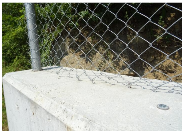
Контролни репери, разположени на укрепителното съоръжение
