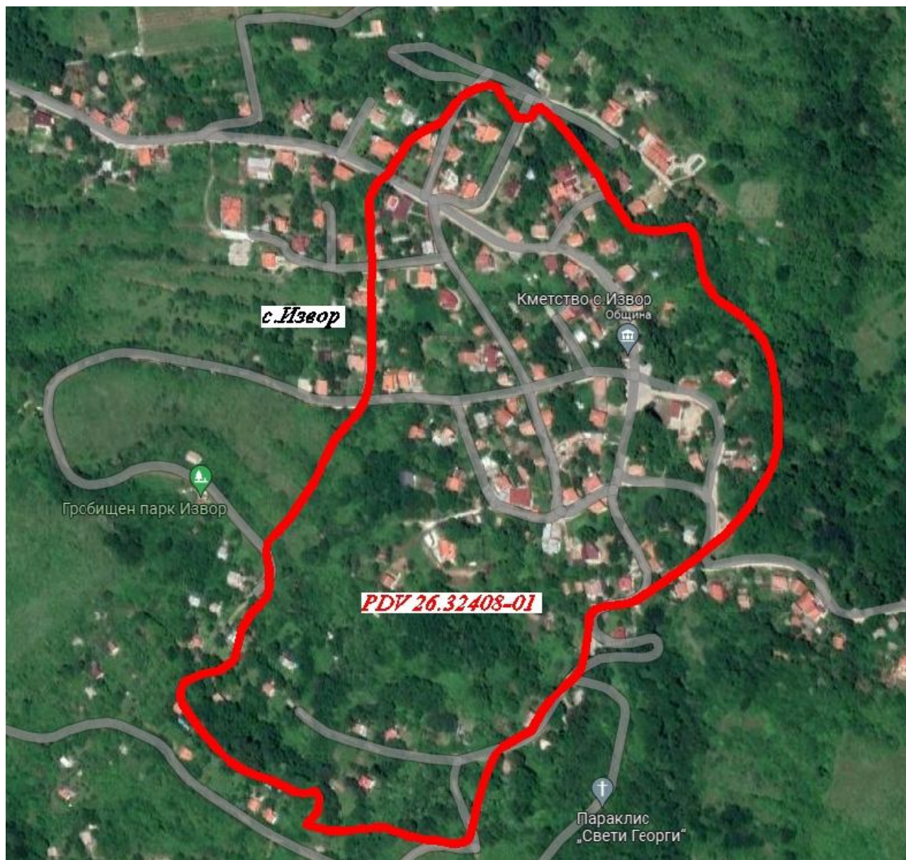
Ситуиране на свлачищния участък върху сателитна снимка на с. Извор
