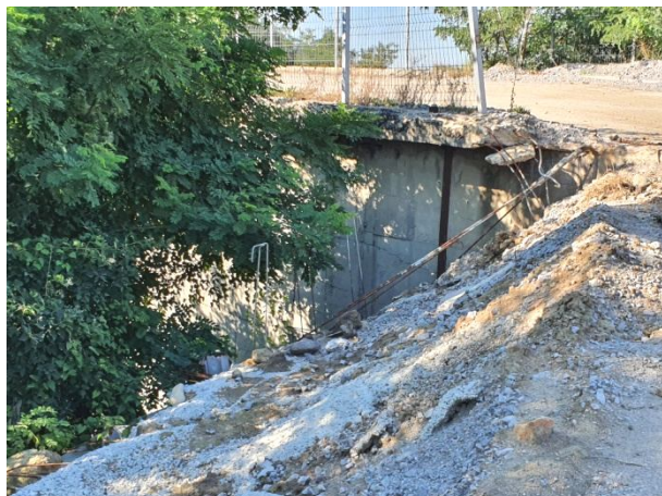
„Самоделно” укрепване на откоса при моста, 2022 Ж.п. линията югоизточно от „депото”, 2022
