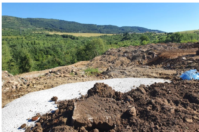
Изхвърляни изкопни земни маси и остатъчен бетон, 2022
