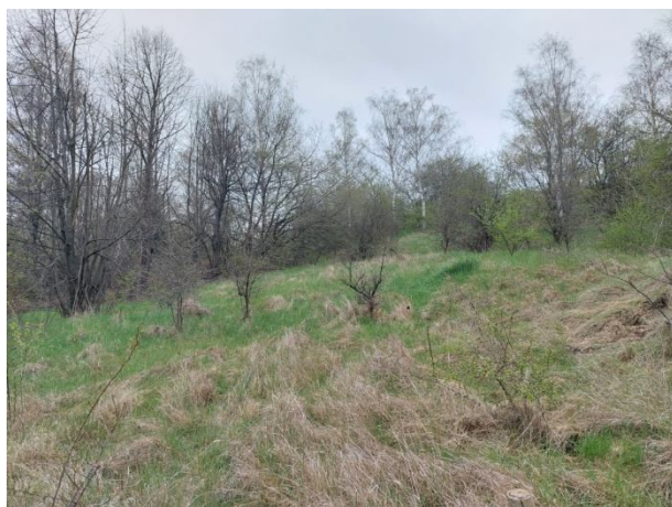
Общ изглед на източната част на свлачищния участък
