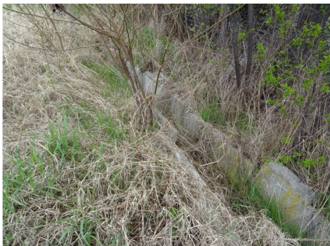
Затлачена и деформирана отводнителна канавка
