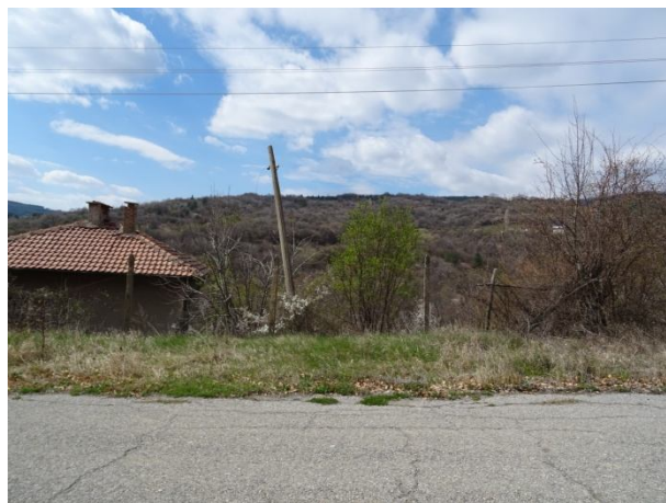
Силно наклонени електрически стълбове по пътя преди левия борд на свлачището
