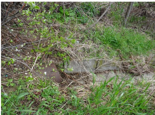
Затлачена и деформирана отводнителна канавка
