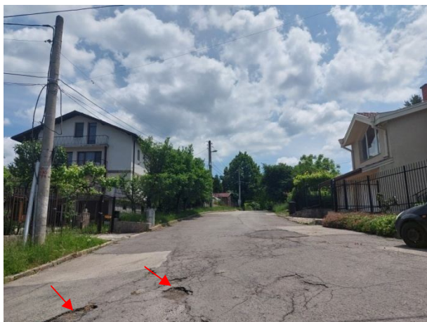
Пукнатини и дупки по асфалтовата настилка на ул. „Малчика”
