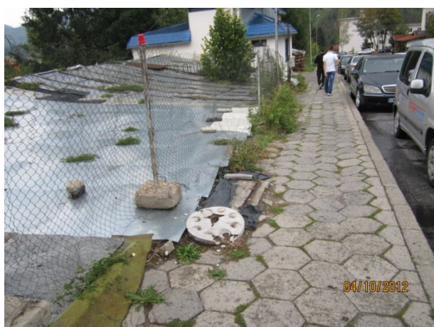
Главен свлачищен откос, покрит с навес на конструкция /октомври, 2012 г./
