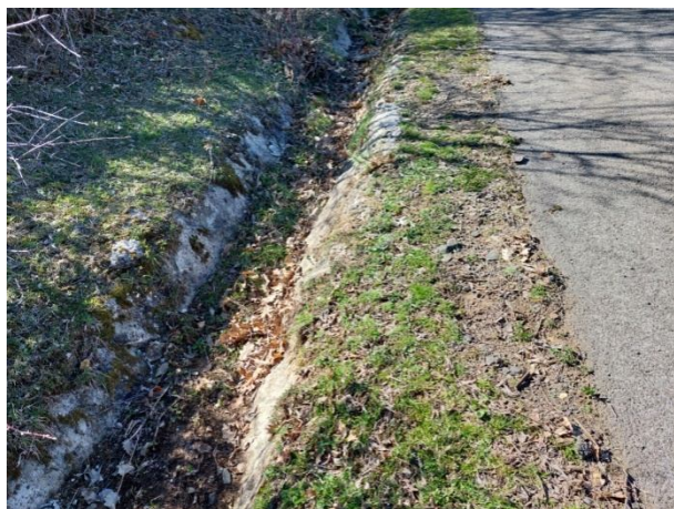
Бетонова крайпътна отводнителна канавка
