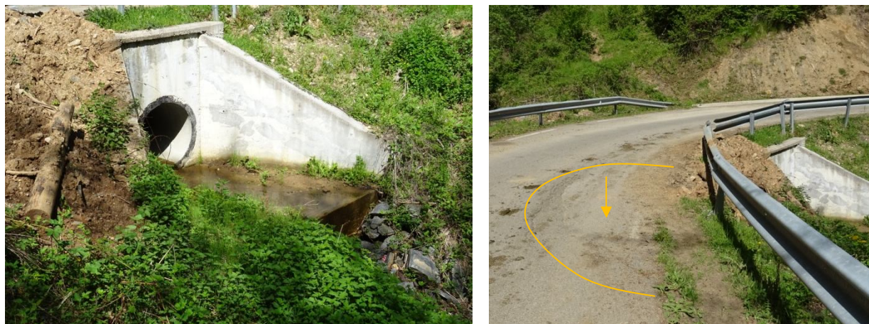
Водосток при югозападния завой /май, 2020 г./
