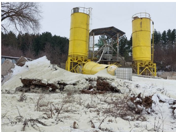
Общ изглед на засегнатия бетонов център и деформациите по терена /2022 г./
