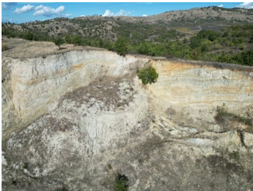
Изглед към свлачищен откос в мест. „Натин рид“
