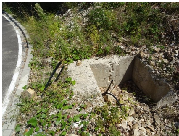
Вток на водостока при десния борд /август, 2022 г./
