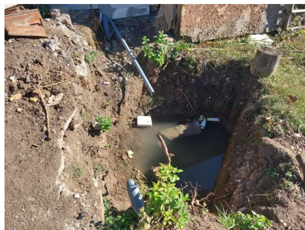
Извършени земно-изкопни работи за подмяна на водопровод
