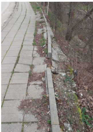
Слягания по тротоара, разположен откъм откоса на р. Бистрица
