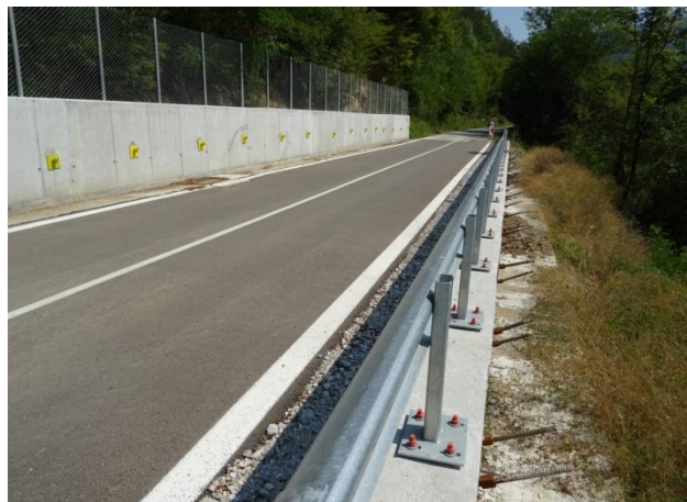
Изградена анкерирана горна опорна стена
