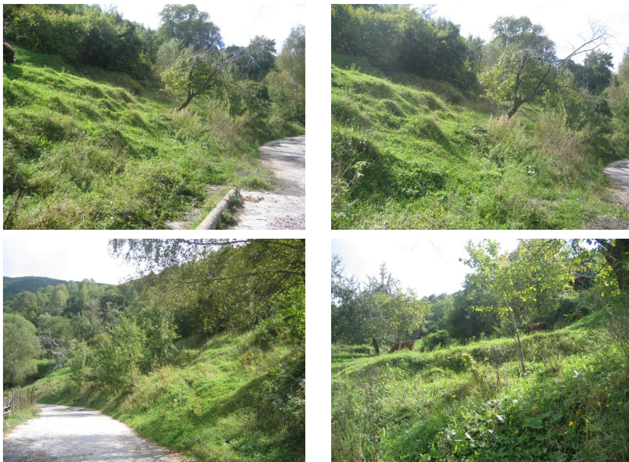
Общ изглед на свлачищния участък, 2005 г.
