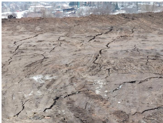
Оформена свлачищна тераса под главния свлачищен откос със значими деформации /2022 г./
