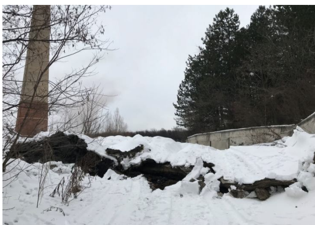
Разрушена бетонова оградна стена и свлачищни деформации /2022 г./
