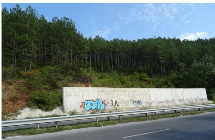
Изглед към укрепения свлачищен участък
