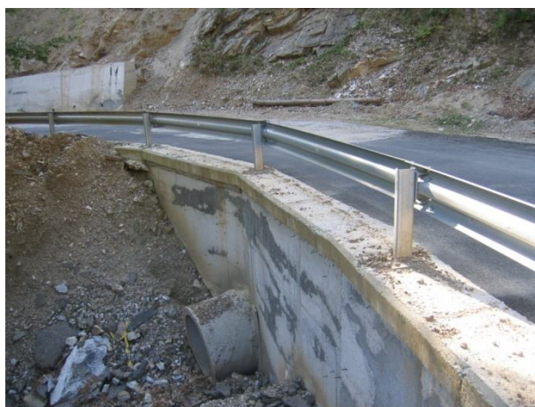
Изградени съоръжения в близост до десния свлачищен борд /август, 2010 г./
