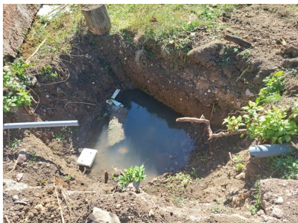
Извършени земно-изкопни работи за подмяна на водопровод
