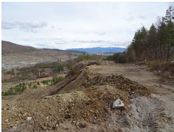
Насипани земни маси в зоната на главния свлачищен откос
