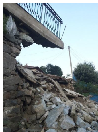
Пропадане и изкривяване на оста на съоръжението /2018 г./
