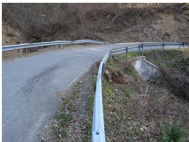
Нарушена зона над водосточно съоръжение /март, 2023 г./
