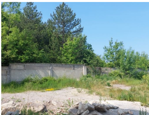
Възстановена бетонова ограда
