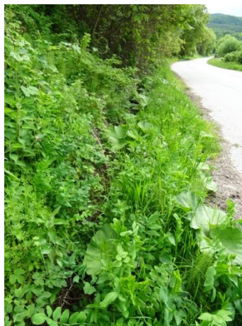
Земна канавка край пътя /15.05.2023 г./
