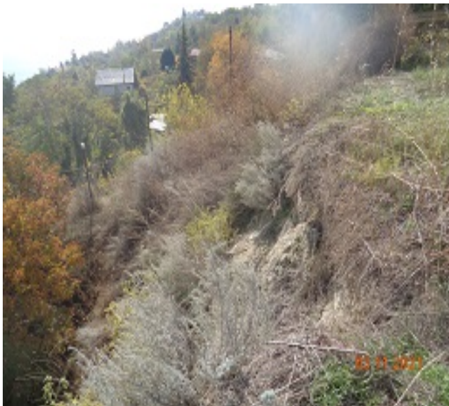
сн.3 - пукнатината-отстъп на свл. „Острия завой“
