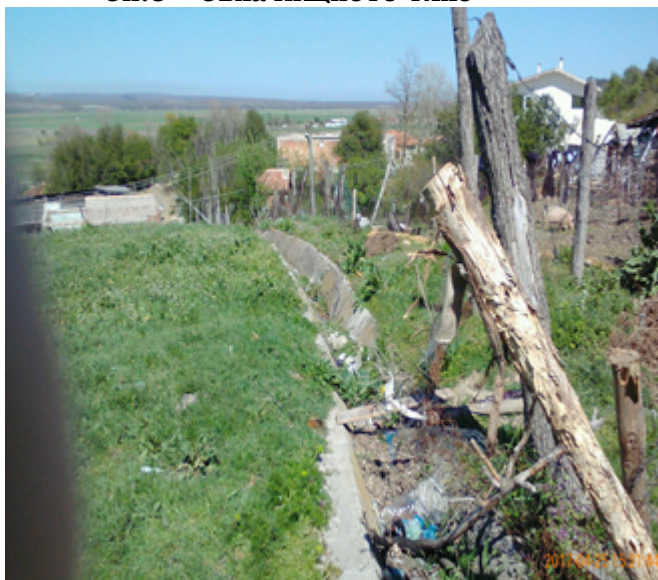
Сн.5,6 – Отводнителни канавки, запълнени със земни маси и отпадъци
