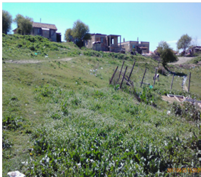
Сн.1– Свлачищният отстъп с къщи над него Сн.2 – Отводнителна канавка под отстъпа
