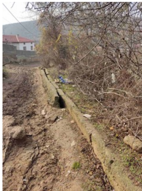
сн.4: компрометирана канавка
