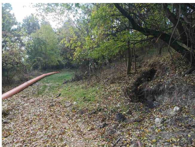
Канализационен колектор в североизточната част на участъка.
