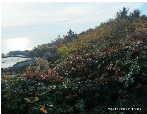
Сн.2 Свлачищен отстъп - изглед -североизток
