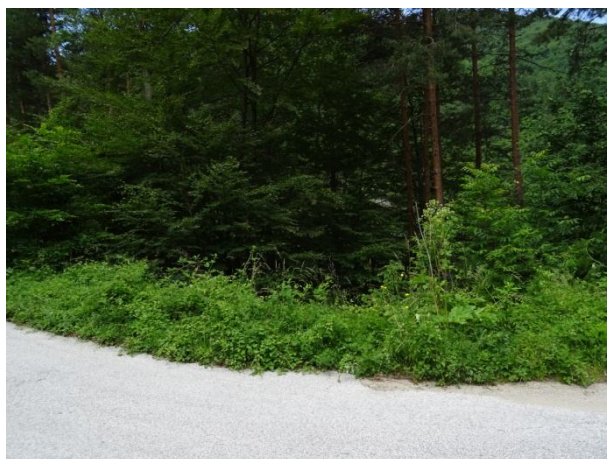
Изглед към обследвания свлачищен участък
