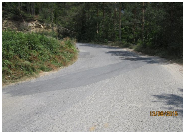
Деформации по платното след преасфалтиране /13.08.2015 г./
