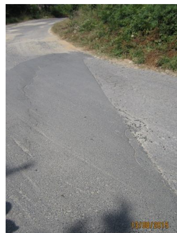
Деформации по платното след преасфалтиране /13.08.2015 г./
