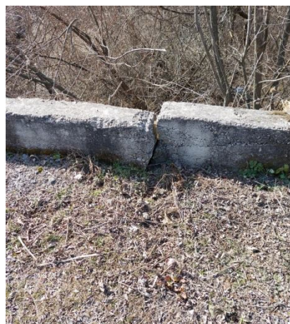
Деформации по укрепителното съоръжение
