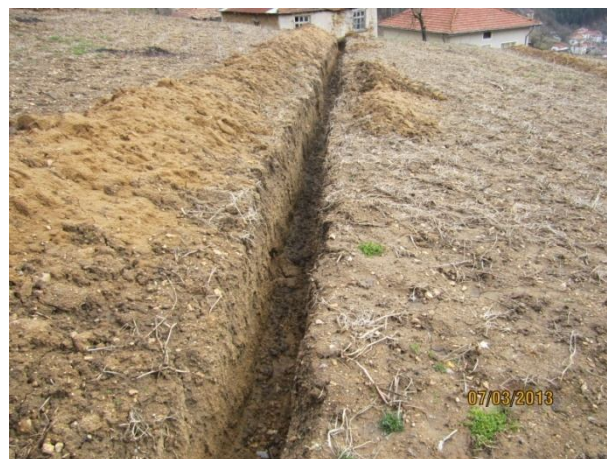
Изпълнени земни повърхностни канавки /март, 2013 г./
