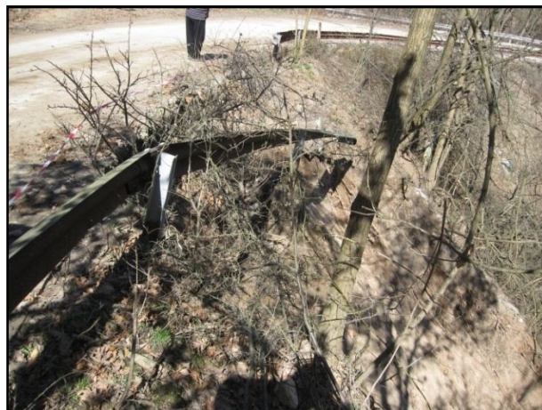
Засегнат склонов участък, 2015 г. Разрушен банкет и част от еластичната ограда, 2015 г.
