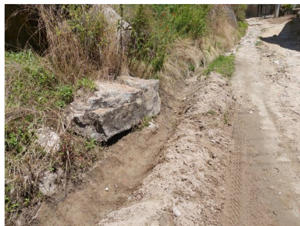
Открита земна канавка по уличното платно
