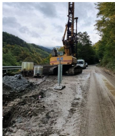
Изпълнение на изливните пилоти \varnothing 600
