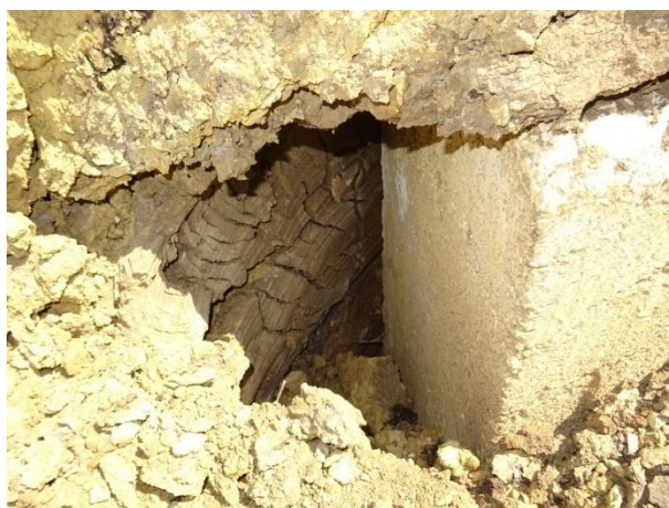
Местоположение на скъсването и контролния репер на стената
