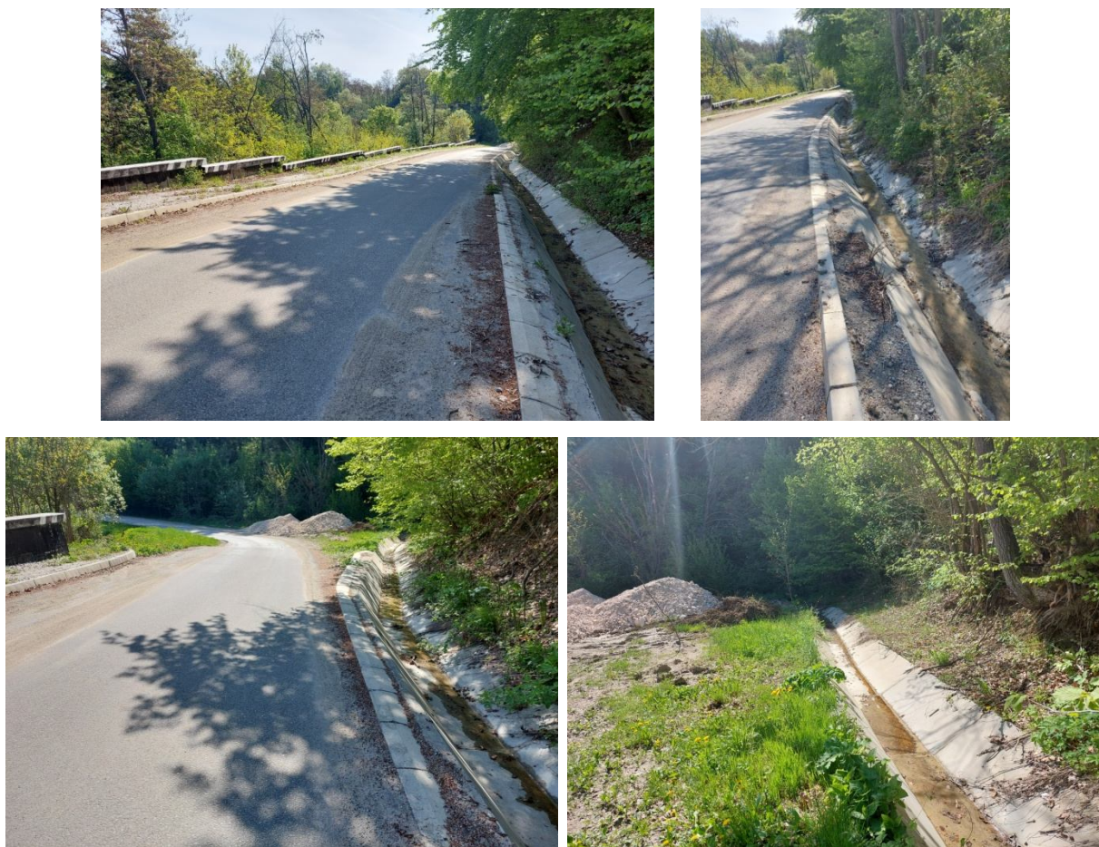
Изглед на бетоновата отводнителна канавка и заустването ѝ в местно дере
