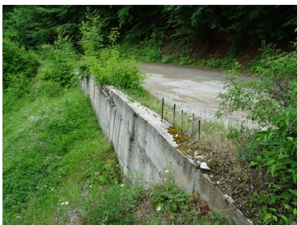
Укрепен свлачищен участък на път
