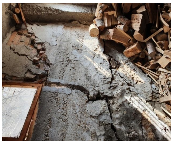
Значими деформации по пристройката на СО1 /април, 2021 г./
