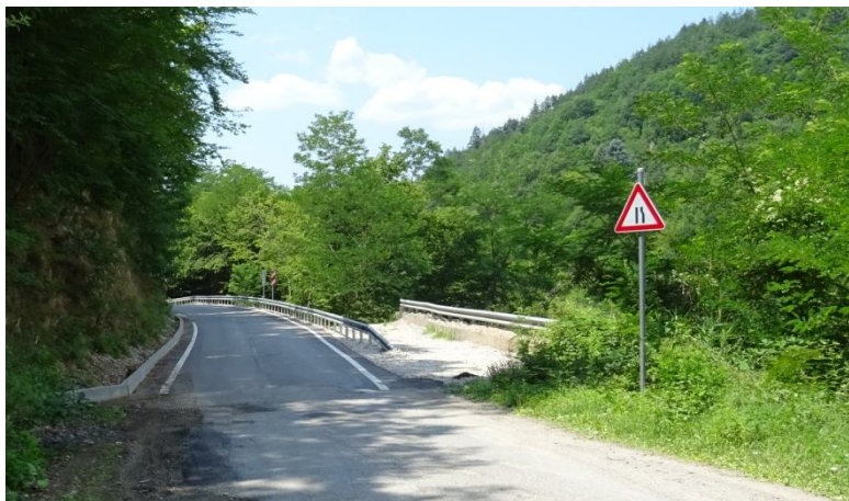
Общ изглед към укрепения свлачищен участък
