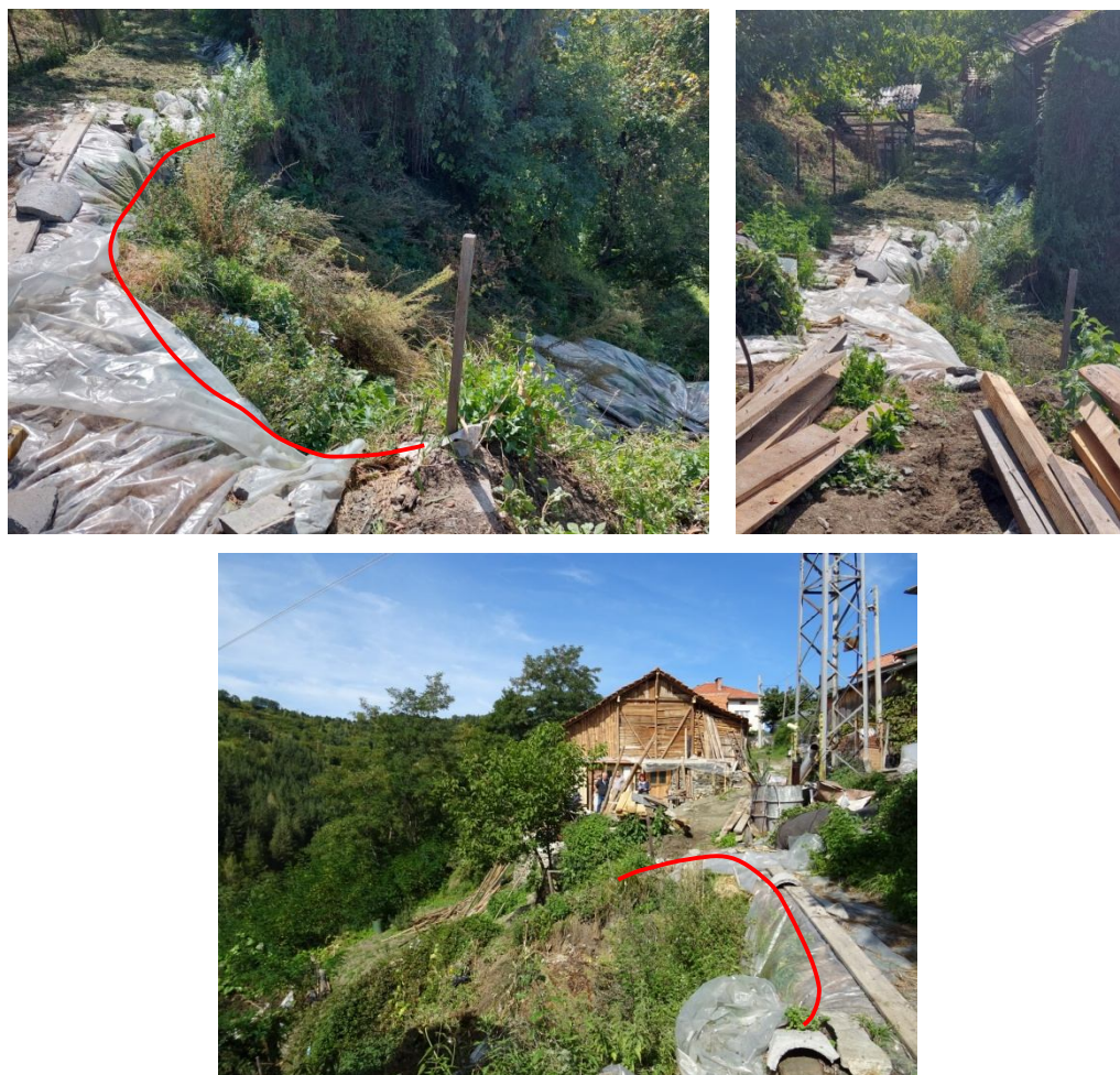
Главен свлачищен откос, покрит с полиетиленово фолио
