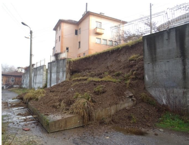
Разрушена подпорна стена, 2021 г.
