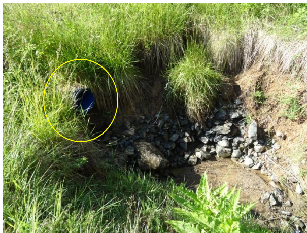
Водосток под пътя
