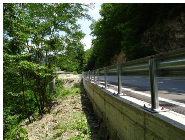
Укрепителна система с ростверк на път SFO 3611 при km 4 +150
