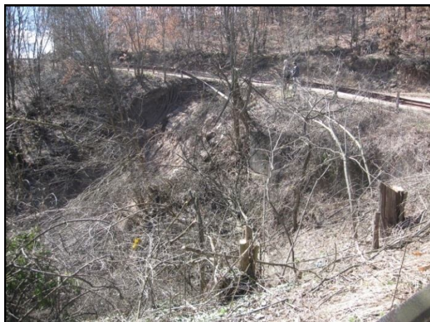
Засегнат склонов участък, 2015 г. Разрушен банкет и част от еластичната ограда, 2015 г.
