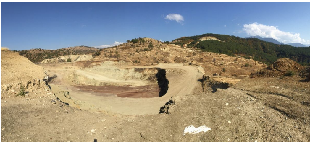
Общ изглед към котлована и свлачищния район /октомври, 2018 г./
