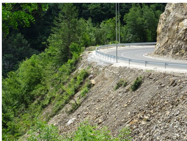
Извършена рехабилитация с изграждане на подпорно съоръжение
