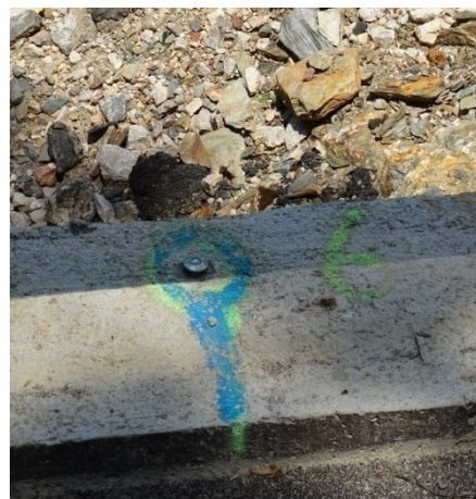
Контролни репери върху новоизграденото укрепително съоръжение
