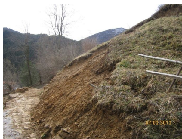
Разрушена каменно-зидана подпорна стена /март, 2013 г./
