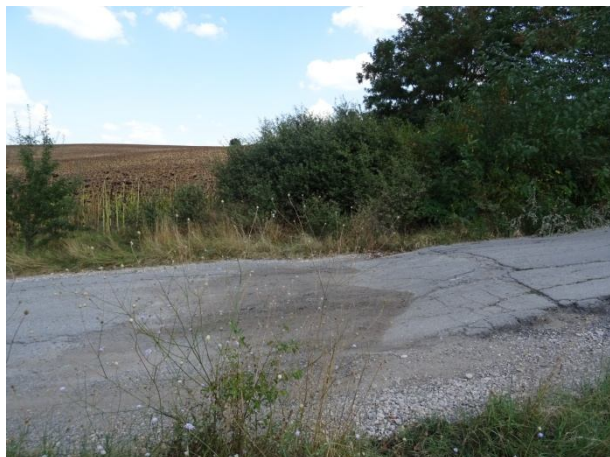
Аварийно заравняване на деформациите
