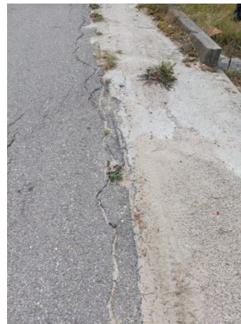
Пукнатини по асфалтовата покривка на пътното платно
