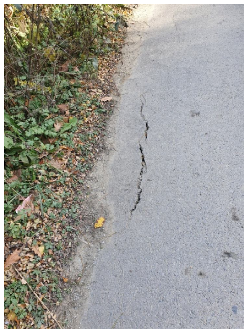
Напуканост на асфалта откъм въздушния пътен откос
