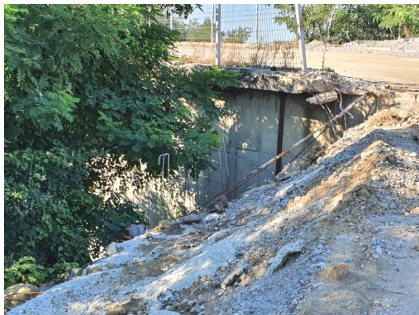
„Самоделно” укрепване на откоса при моста Ж.п. линията югоизточно от „депото”
