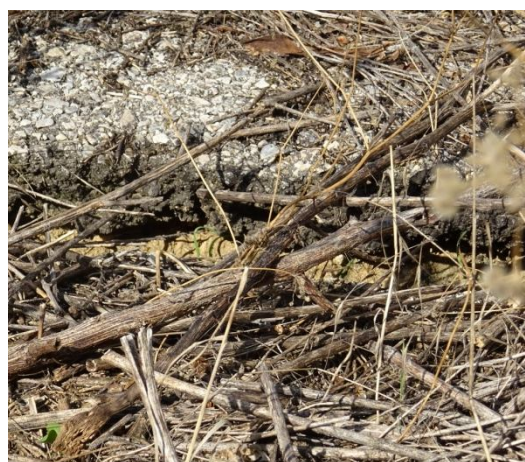
Отместване между секциите на стената
