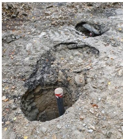
Изпълнение на изливните пилоти \varnothing 600
