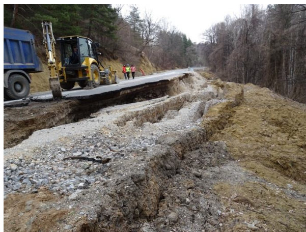
Разрушени и отместени габиони /09.03.2021 г./
