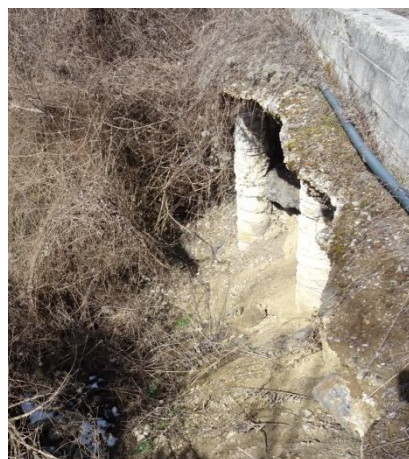
Деформации по укрепителното съоръжение
