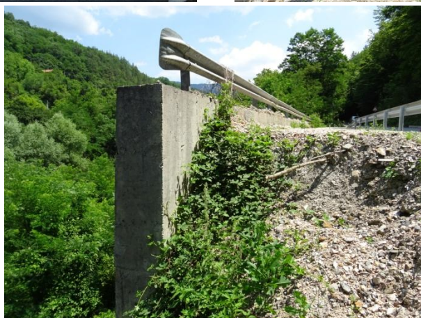
Застъпване на укрепителните съоръжения в участъка
