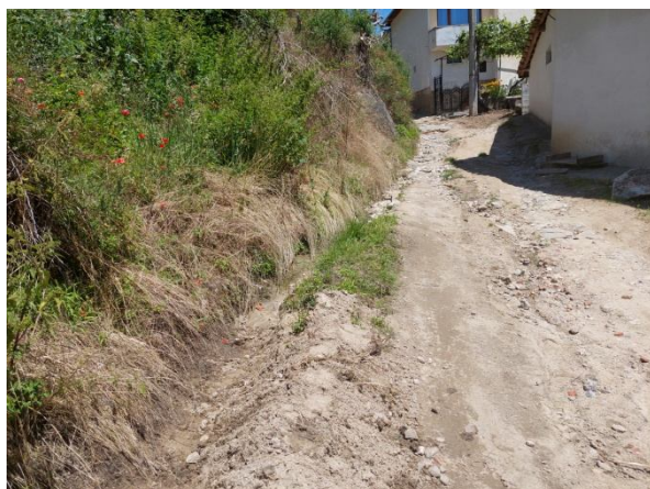
Открита земна канавка по уличното платно
