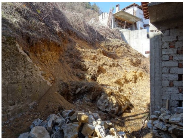
Разрушена подпорна стена
