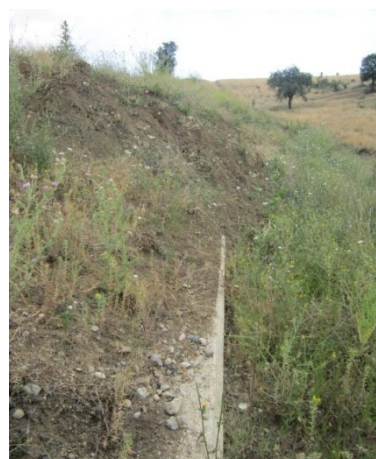
Натрупани земни маси /вал на изтласкване/ върху ростверка /юли, 2017 г./
