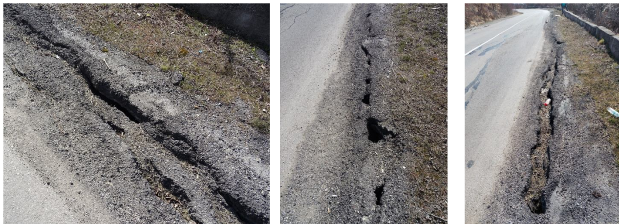
Денивелирана деформация на срязване на пътното платно
