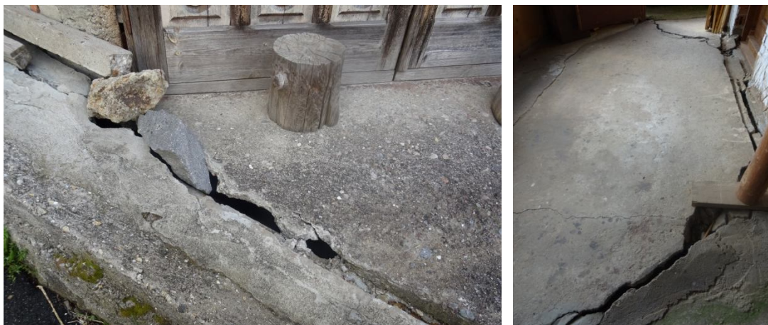
Деформации по плочата на затворената тераса в СО2 /април, 2021 г./
