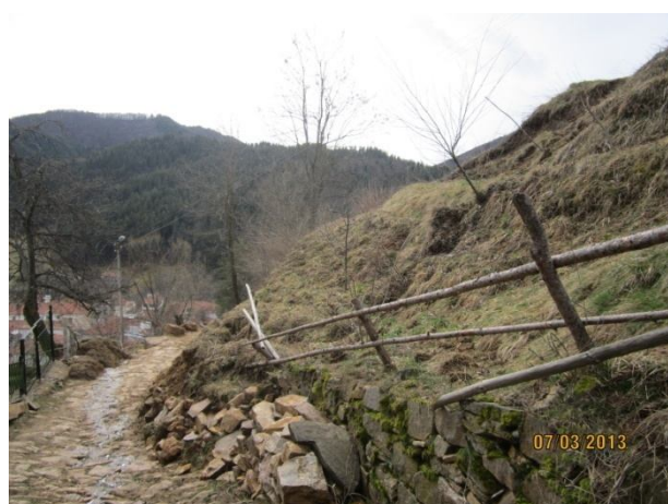
Разрушена каменно-зидана подпорна стена /март, 2013 г./
