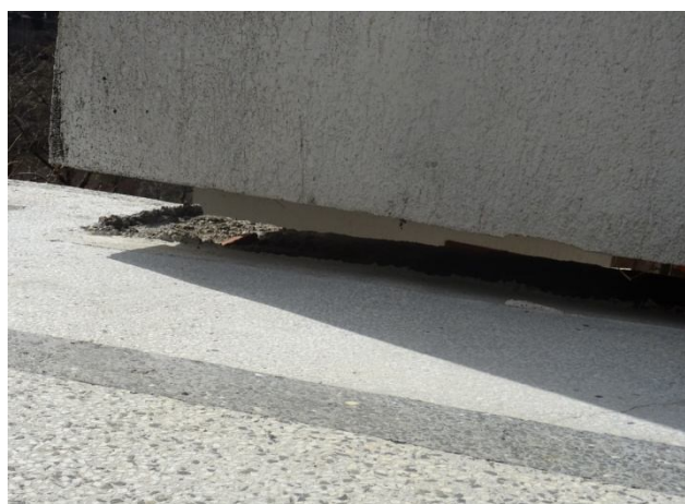
Значими деформации по пристройката на СО1 /април, 2021 г./
