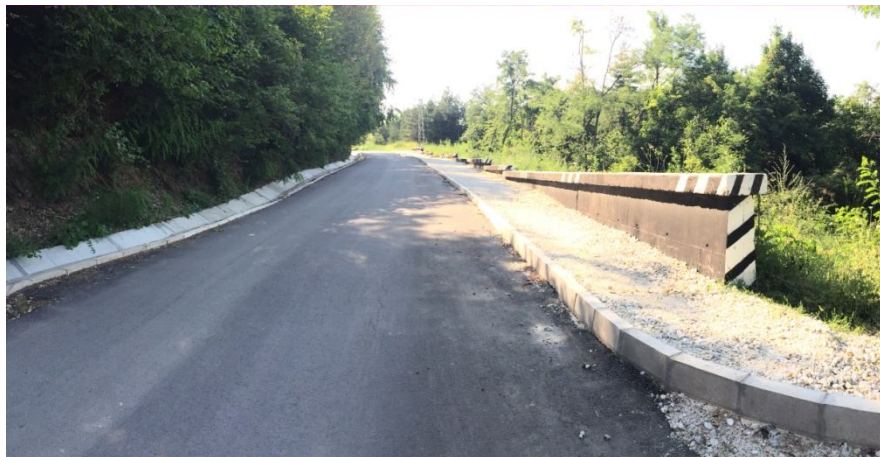
Изглед към укрепения свлачищен участък, 2019 г.
