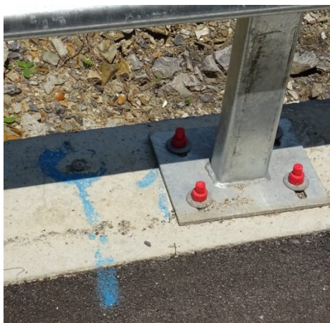
Контролни репери върху новоизграденото укрепително съоръжение
