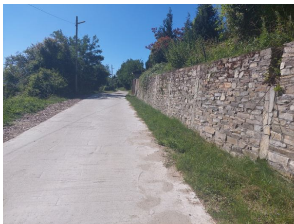
Възстановено улично платно чрез бетонова настилка
