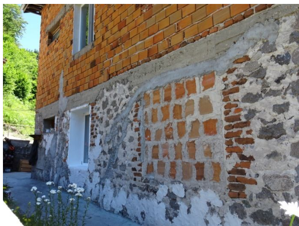
Опит за козметично заличаване на деформации в границите на свлачищния участък
