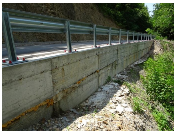
Укрепителна система с ростверк на път SFO 3611 при km 4 +150
