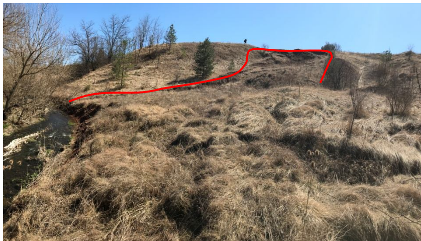
Общ изглед на свлачищния участък
