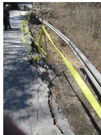
Общ изглед от засегнатия пътен участък, разрушения банкет и деформираната мантинела
