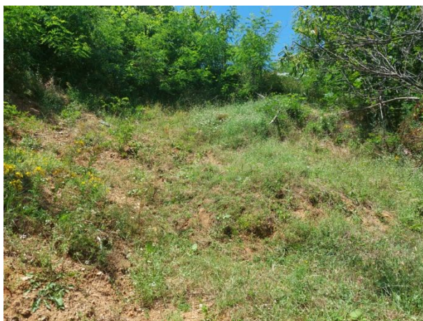
Главен свлачищен откос
