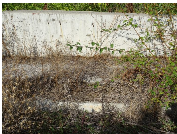
Отместване между секциите на стената
