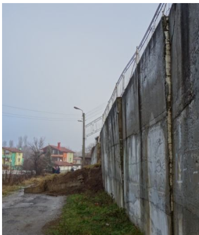
Деформации по подпорната стена, 2021 г.
