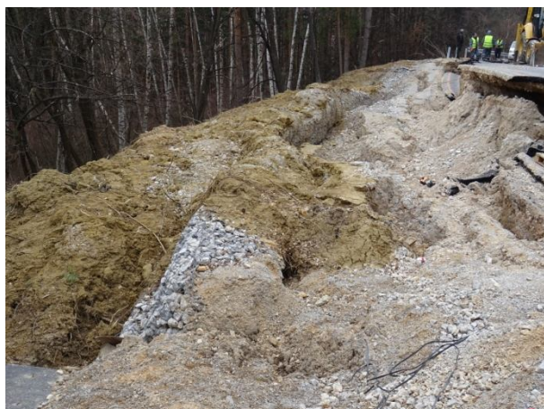
Разрушени и отместени габиони /09.03.2021 г./
