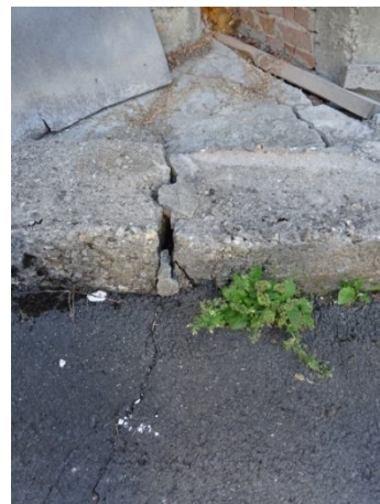
Стари напуквания по асфалтовото покритие на ул. „Калин Найденов” № 1
