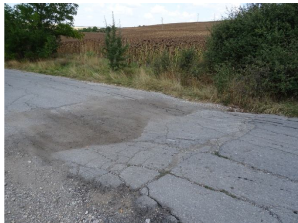
Аварийно заравняване на деформациите
