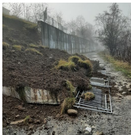
Разрушена подпорна стена, 2021 г.
