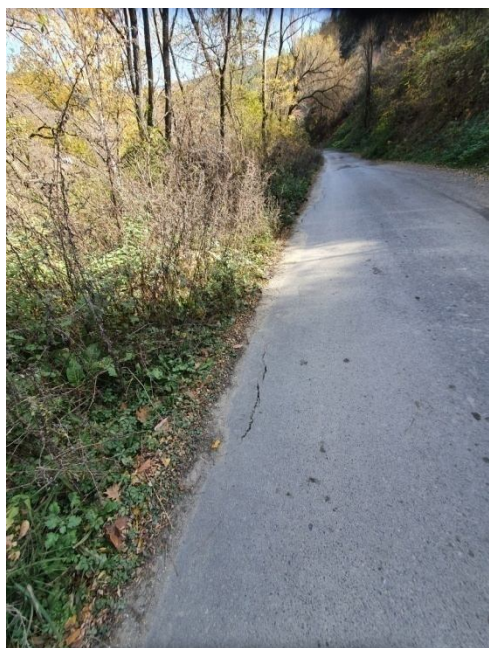
Напуканост на асфалта откъм въздушния пътен откос
