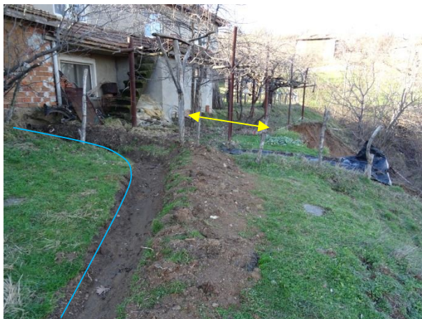
Отстояние на откоса и отвеждане на повърхностния отток, 2021 г.
