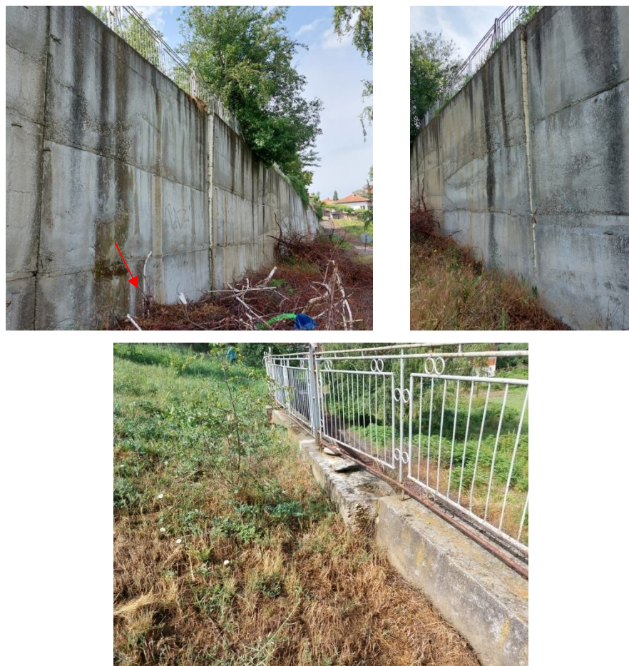
Разместване на ламелите на стената по вертикалните фуги
