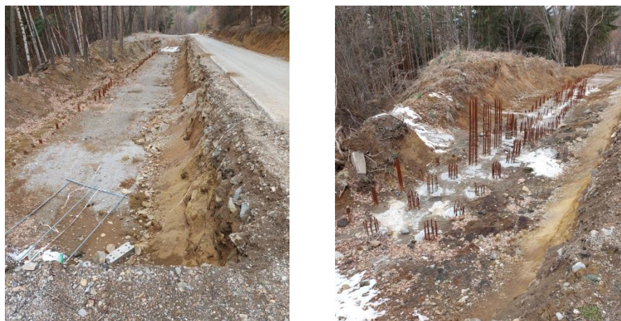
Строителен изкоп със започната пилотна конструкция
