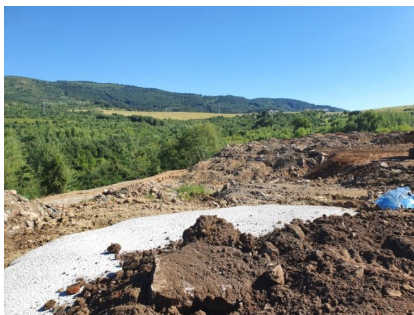
Изхвърляни изкопни земни маси и остатъчен бетон
