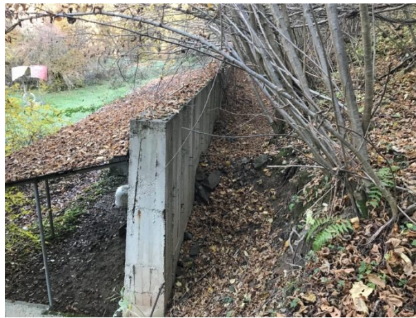
Състояние на подпорното съоръжение /ноември, 2022 г./
