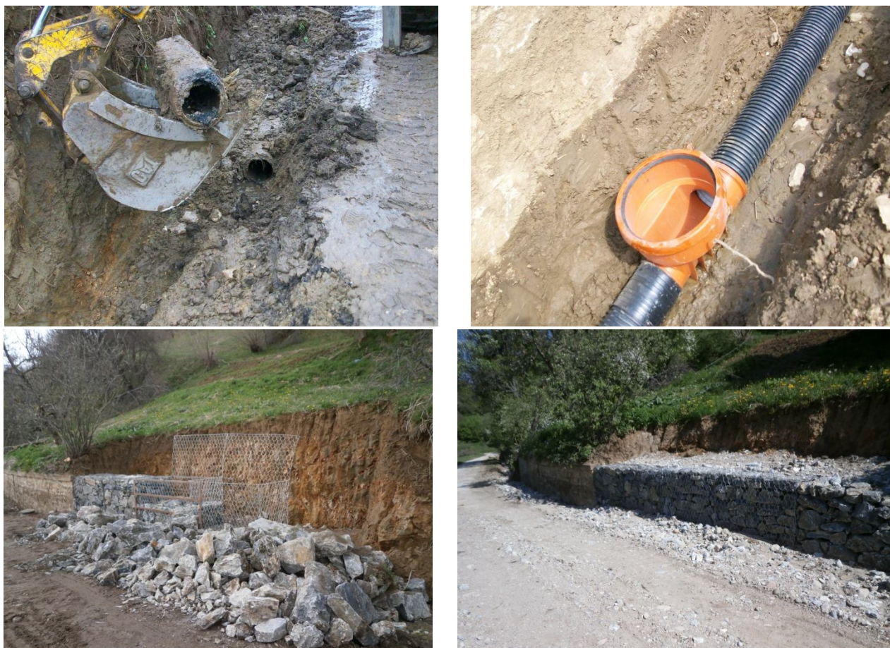
Етапи от аварийно-възстановителните работи /2015 г./
