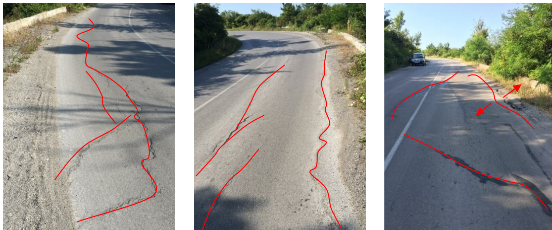
Деформации по платното на път PER 2099 /2019 г./
