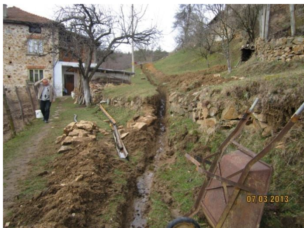
Изпълнени земни повърхностни канавки /март, 2013 г./
