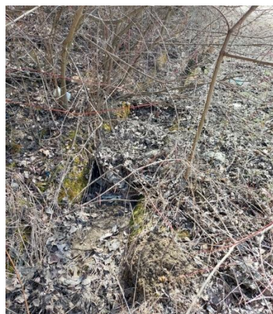
Нефункционираща отводнителна крайпътна канавка
