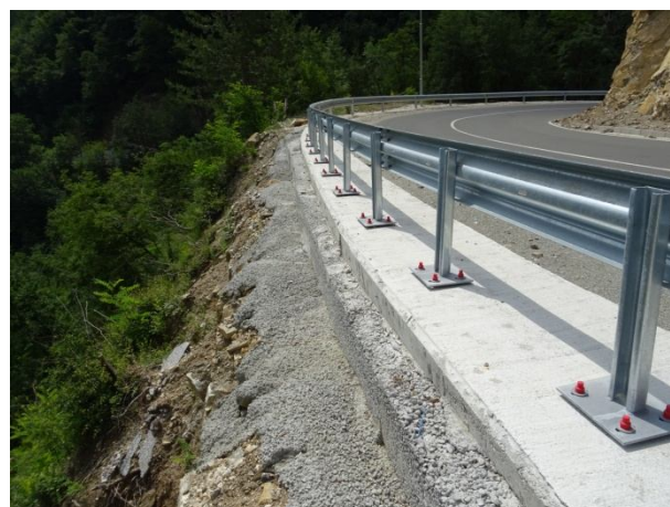
Извършена рехабилитация с изграждане на подпорно съоръжение
