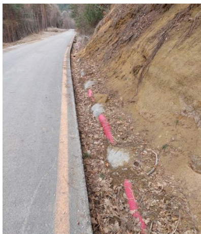
Положена тръба за отвеждане на повърхностните води в района на свлачището
