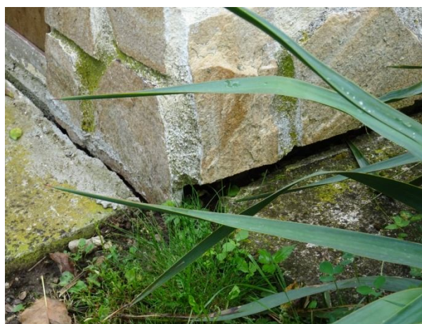
Деформации по фундамента на санитарен възел
