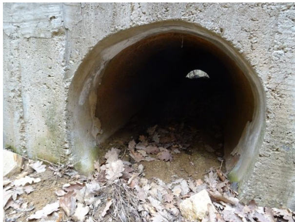
Възстановен водосток при засегнатия участък
