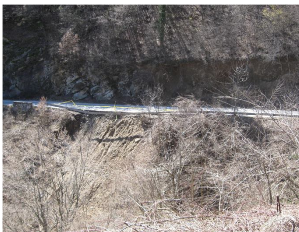
Общ изглед от засегнатия пътен участък, разрушения банкет и деформираната мантинела
