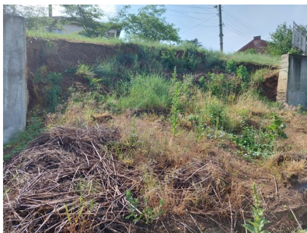
Общ изглед на свлачищния участък
