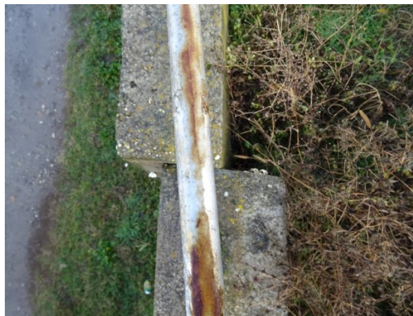
Деформации по подпорната стена, 2021 г.
