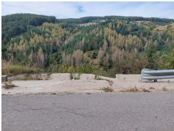
Пукнатини по асфалтовата покривка на пътното платно
