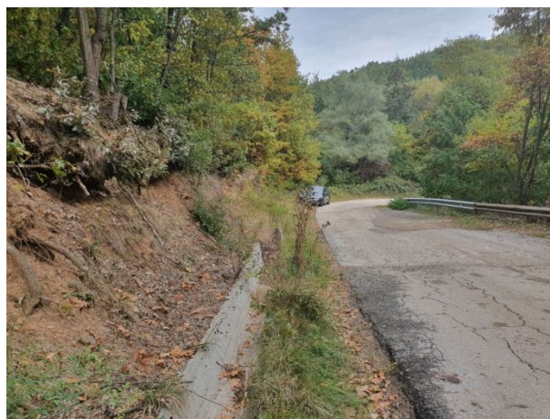
Затлачена отводнителна канавка
