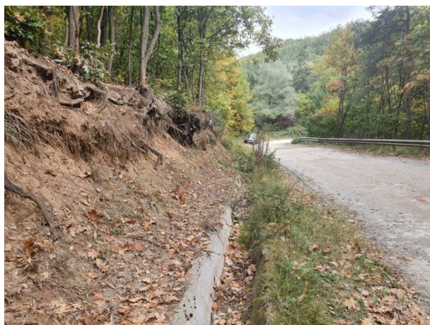
Затлачена отводнителна канавка
