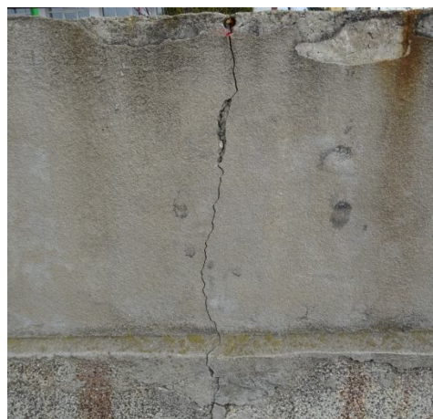
Деформации по бетонова ограда на ОДЗ „Дружба” /март, 2021 г./
